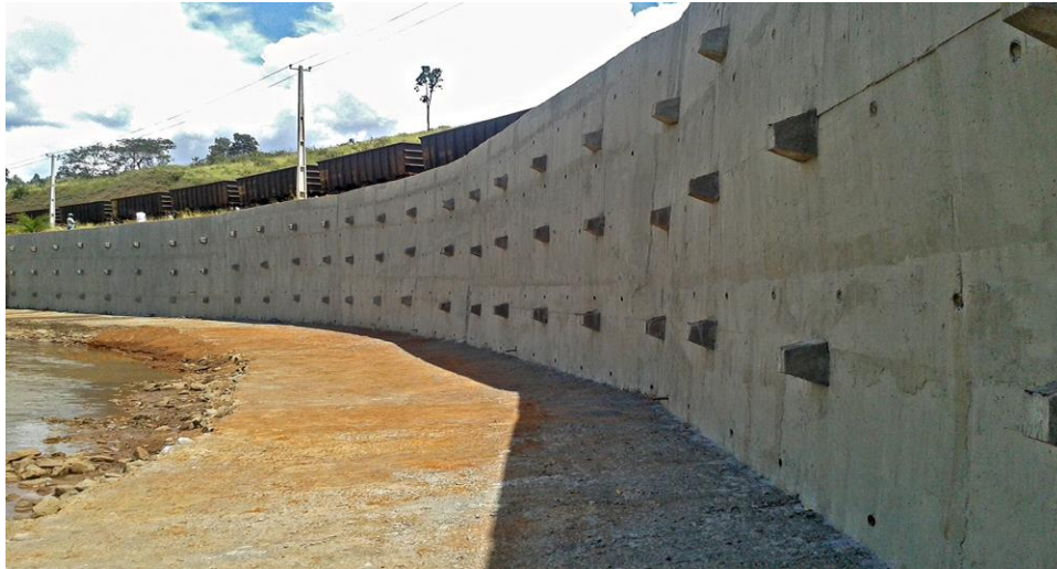
Figura 15 - Cortina atirantada protendida em concreto armado
