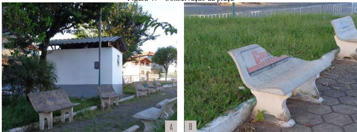
(A) ponto de táxi e bancos, (B) banco rompido. Fonte: Autora, 2021.
