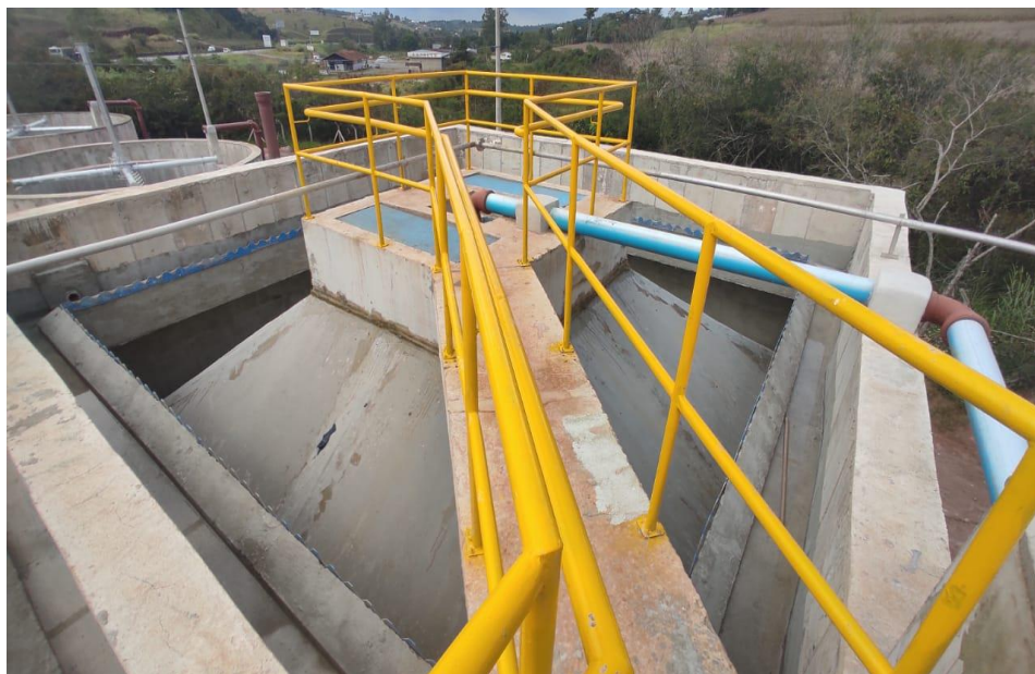
Figura 11 – Reator anaeróbio
