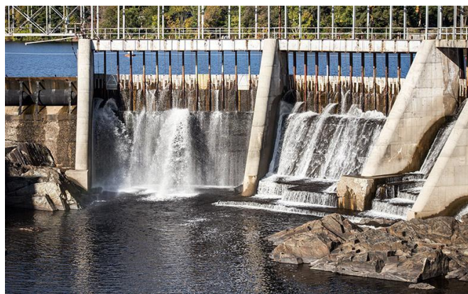
Figura 8 - Barragem de concreto compactado
