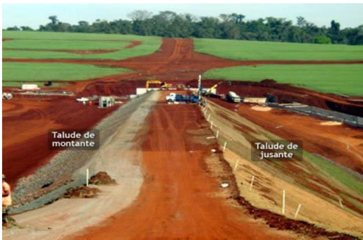
Figura 26 - Taludes após proteções
