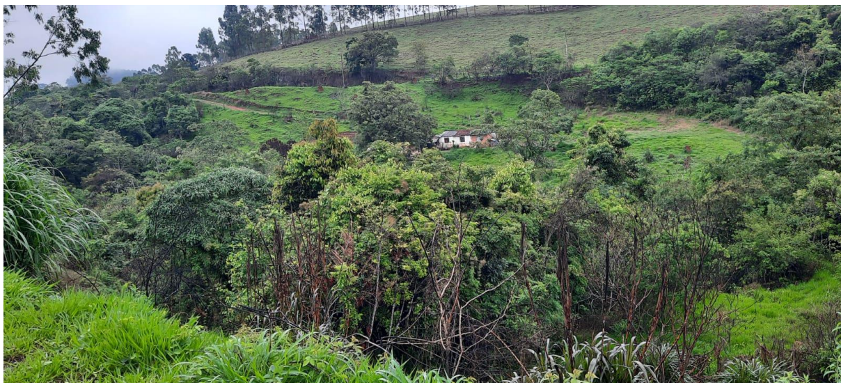
Figura 13 - Vista da ombreira direita
