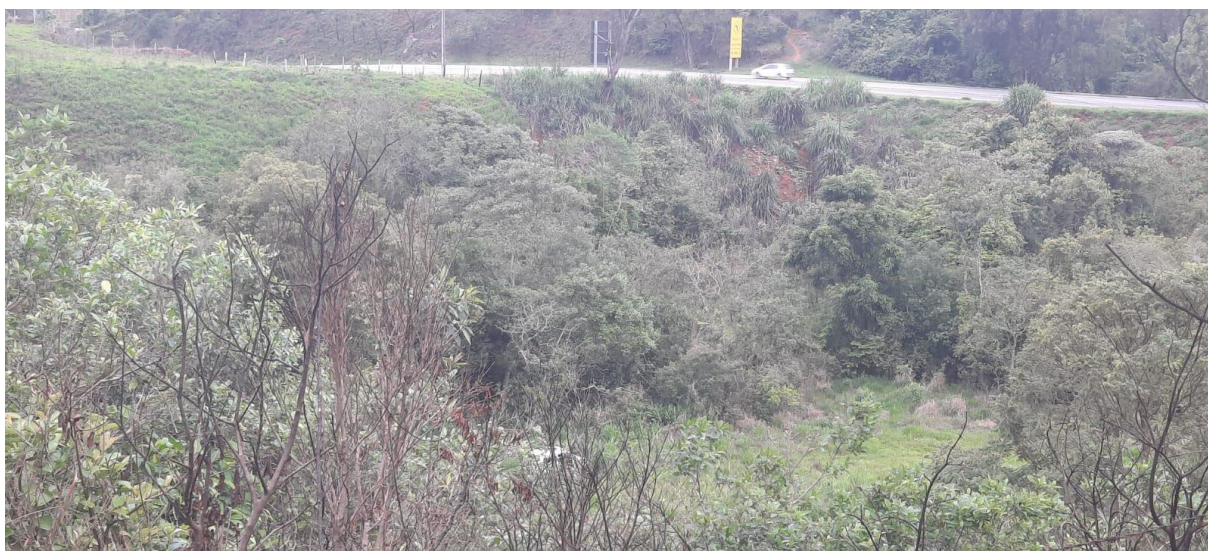
Figura 14 - Vista da ombreira esquerda
