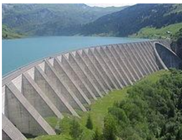
Figura 6 – Barragem em contraforte Roselend Dam
