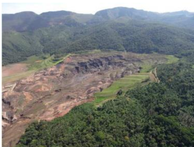
Figura 11 - Vista aérea do rompimento da Barragem 1, em direção ao norte
