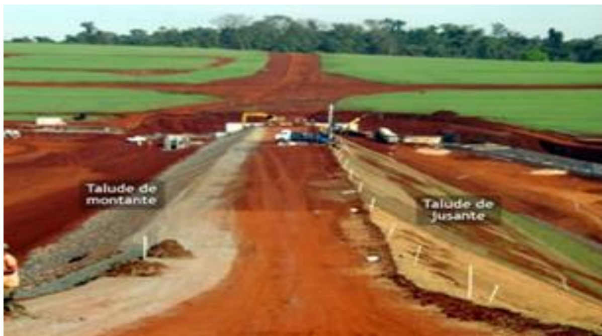
Figura 38 - Taludes após proteções
