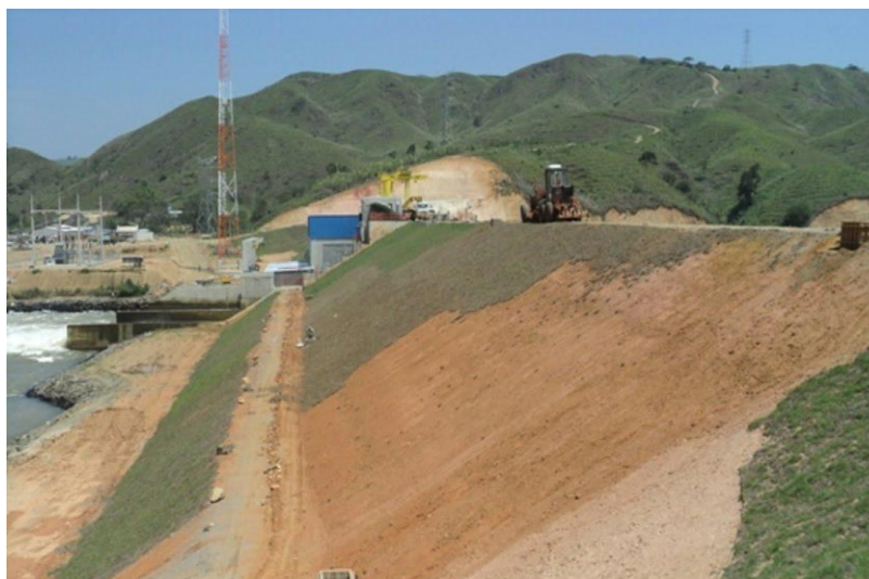
Figura 3 - Barragem de Marzagão
