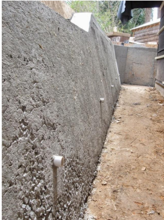
Figura 6– Drenagem em muro de arrimo por barbacãs
