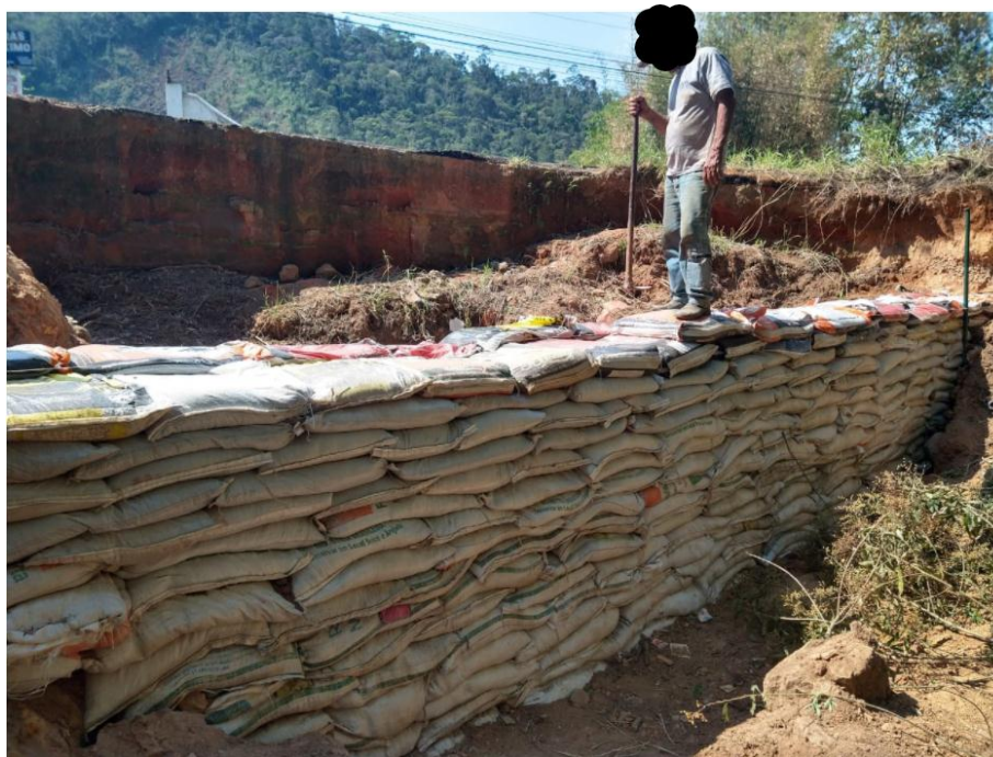
Figura 9– Disposição e compactação de muro de saco solo-cimento
