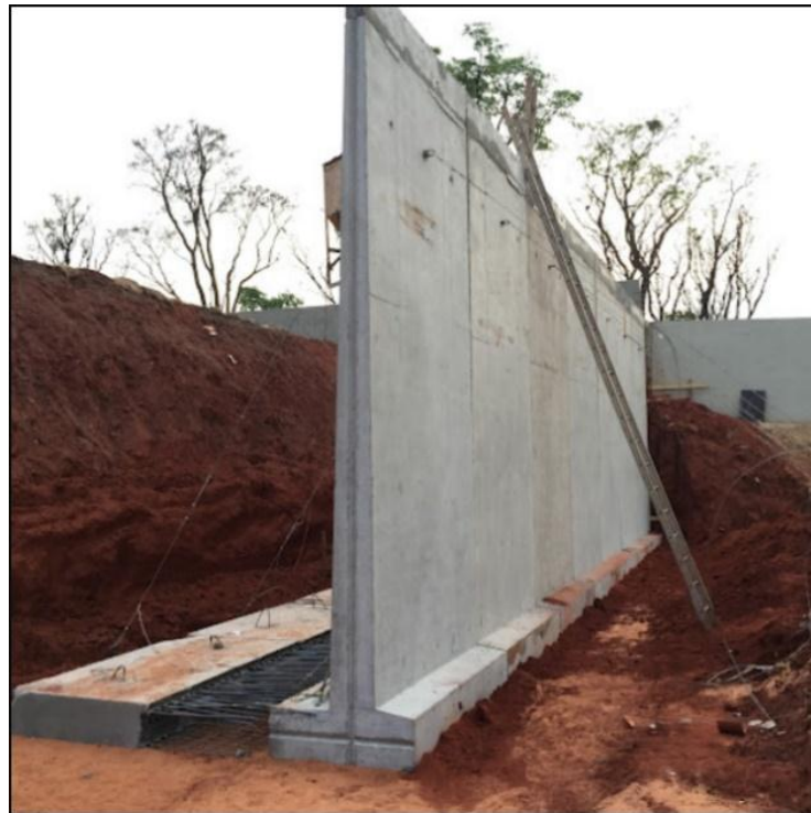
Figura 11 – Muro de flexão voltado para o talude
