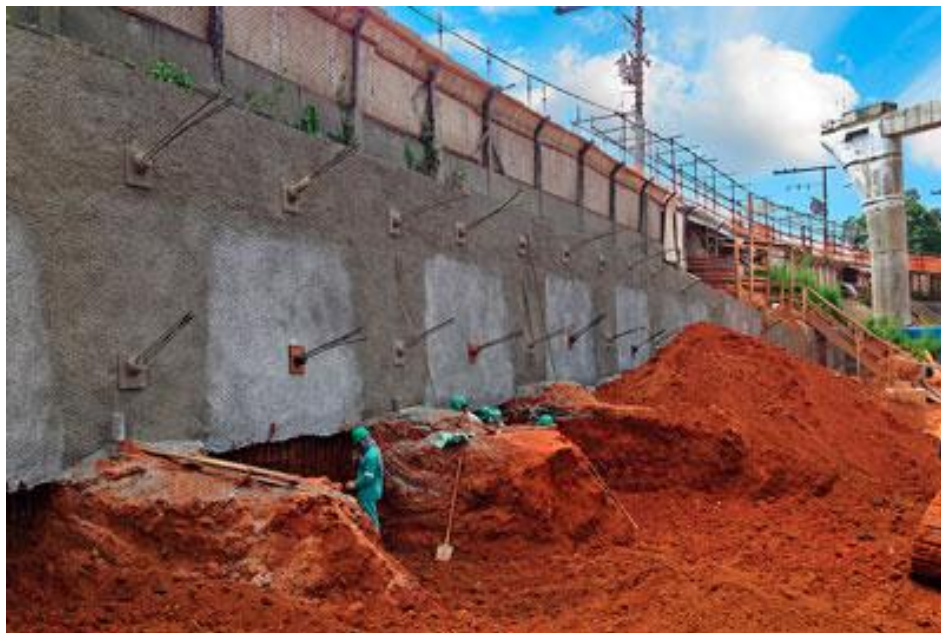
Figura 21– Cortina de Estacas Atirantadas
