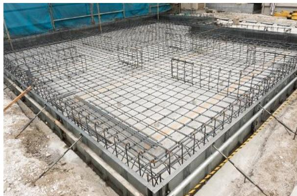
Fonte: Radier em concreto armado (2020) <sup>11</sup>
