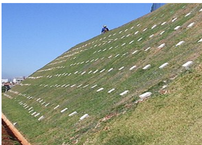
Figura 14- Biomanta em formato de placa grampeada
