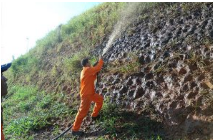
Figura 15- Aplicação de hidrossemeadura
