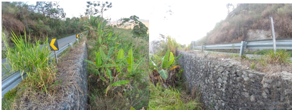
Figura 16 - Muros de Gabiões
