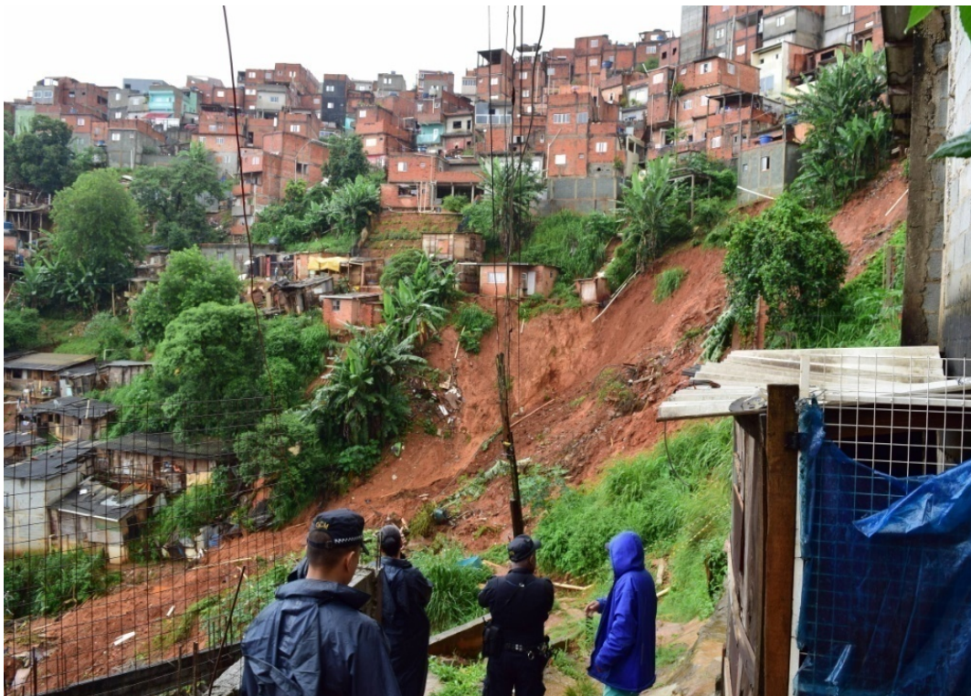
Figura 7- Deslizamento de encosta
