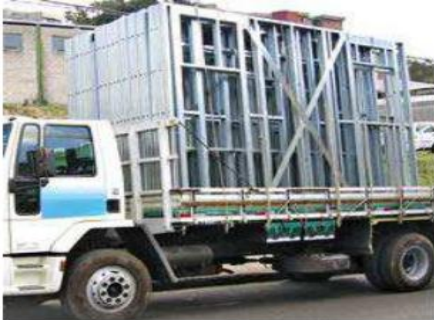
Figura-6 Painéis de LSF produzidos em fábrica e transportados para obra
