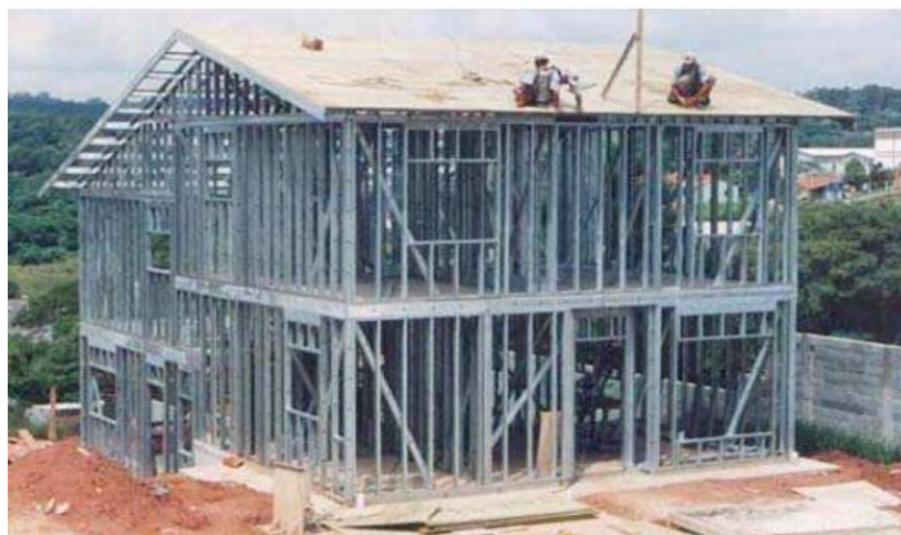
Figura 4- Execução da primeira obra em LSF no Brasil
