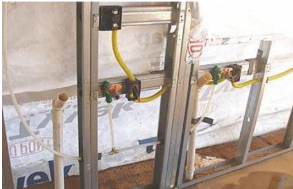
Figura 14 -Instalações elétricas e hidráulicas em sistema LSF
