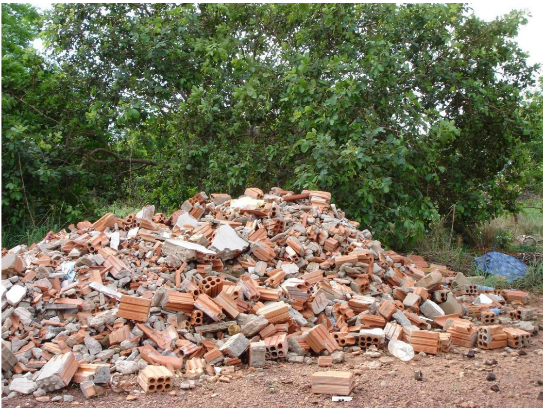
Figura 7 – Desperdício de materiais na construção civil.
