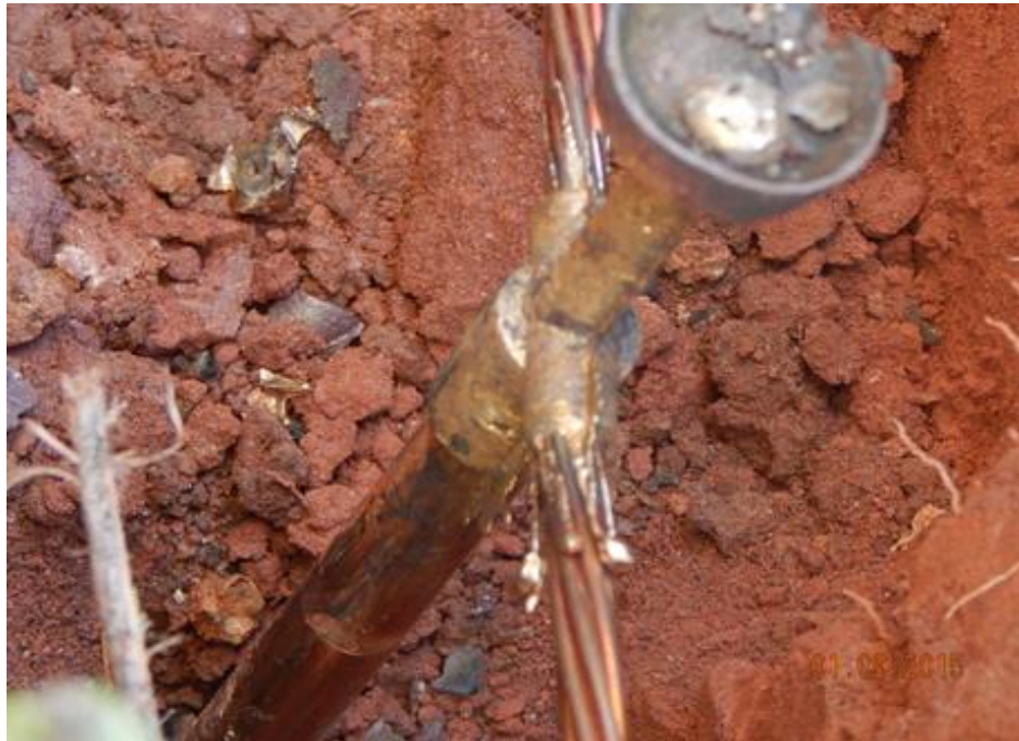
Figura 16 - Montagem do aterramento da Usina Solar dos Lotte
