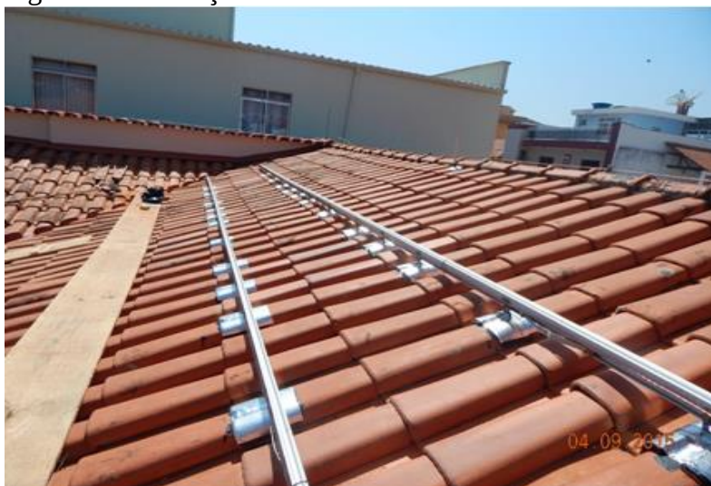
Figura 13 – Vedação da base da Usina Solar dos Lotte
