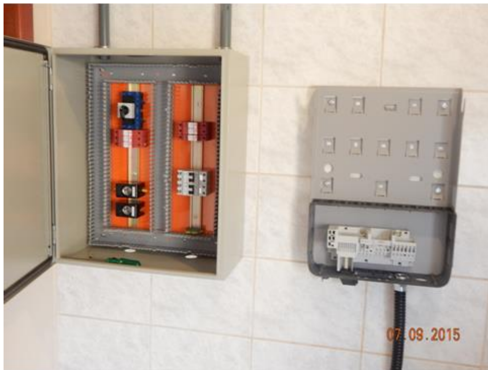
Figura 17 – Montagem de quadro de distribuição de circuitos (QDC) da Usina Solar dos Lotte
