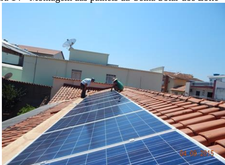
Figura 14 - Montagem das paineis da Usina Solar dos Lotte
