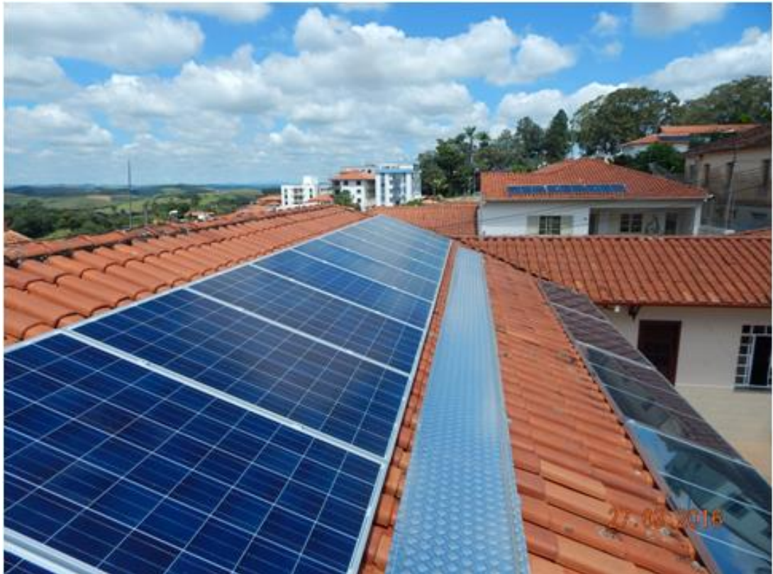
Figura 15 – Finalização da Montagem dos painéis da Usina Solar dos Lotte
