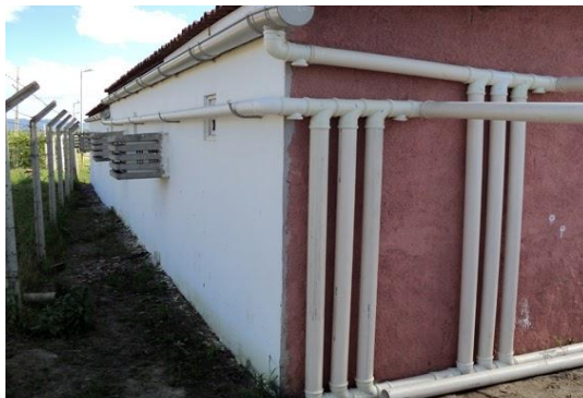
Figura 7 - Demonstração de desvio das primeiras águas.
