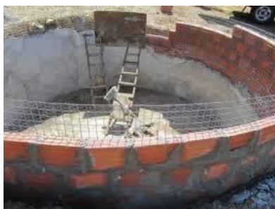
Figura 10 - Cisterna de tijolo.
