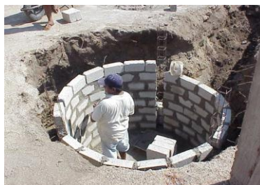
Figura 13 - Começo da construção cisterna de cal.
