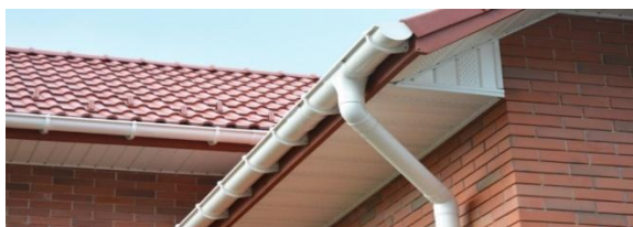
Figura 6 - Demonstração de calha e condutor.
