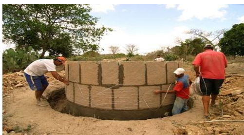
Figura 9 - Cisterna de placa de cimento.
