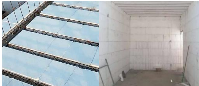
Figura 20 – Laje em sistema ICF
