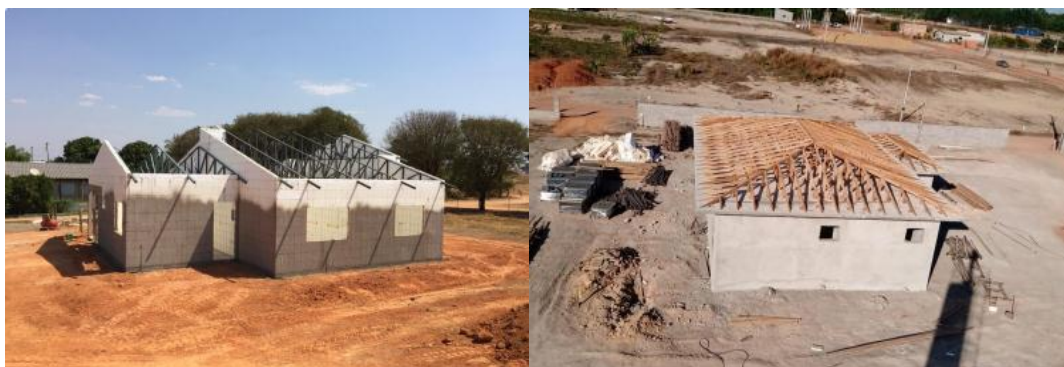
Figura 21 – Cobertura em construções com formas de ICF
