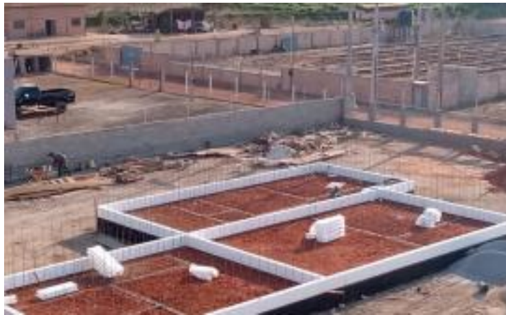
Figura 15 – Levantamento da primeira fiada das formas de EPS
