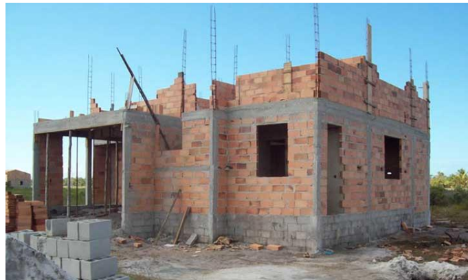
Figura 7 – Construção em alvenaria convencional
