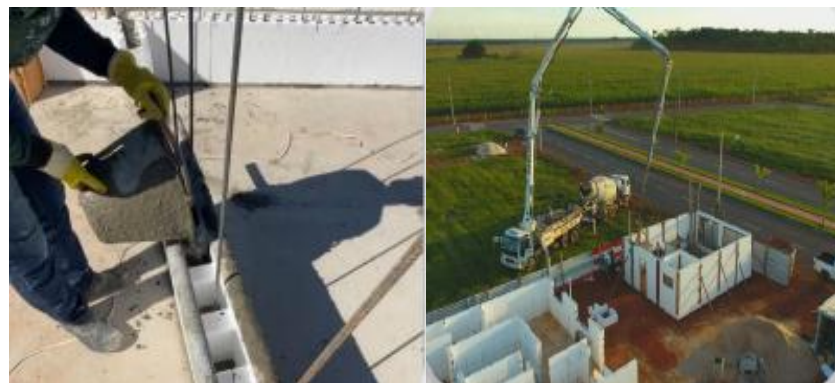
Figura 17 – Concretagem manual e por bombeamento
