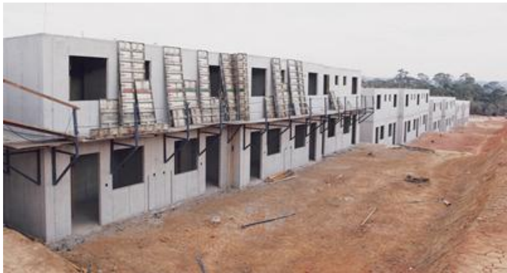
Figura 5 – Construção em paredes de concreto
