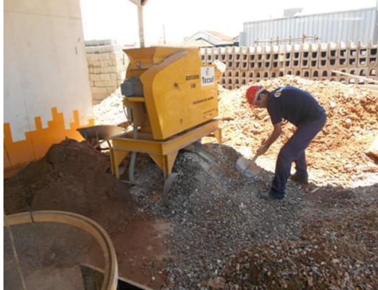
Figura 22 – Canteiro de obras de construção em alvenaria convencional
