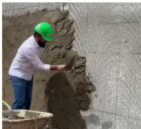
Figura 19 – Revestimento de formas de EPS
