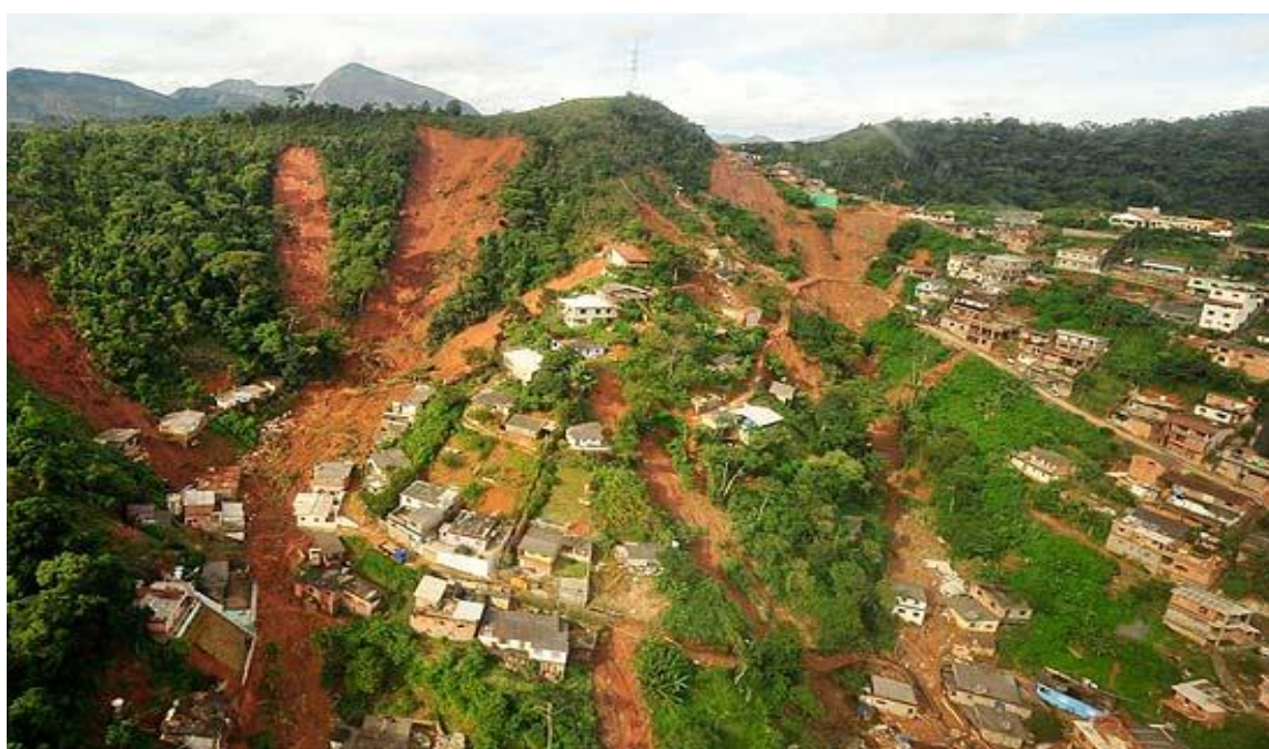
FIGURA 2- Deslizamentos e ocupação irregular em Nova Friburgo (RJ)
