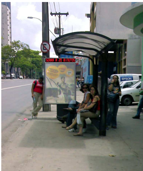
Figura 6 – Ponto de ônibus com letreiro digital instalado.
