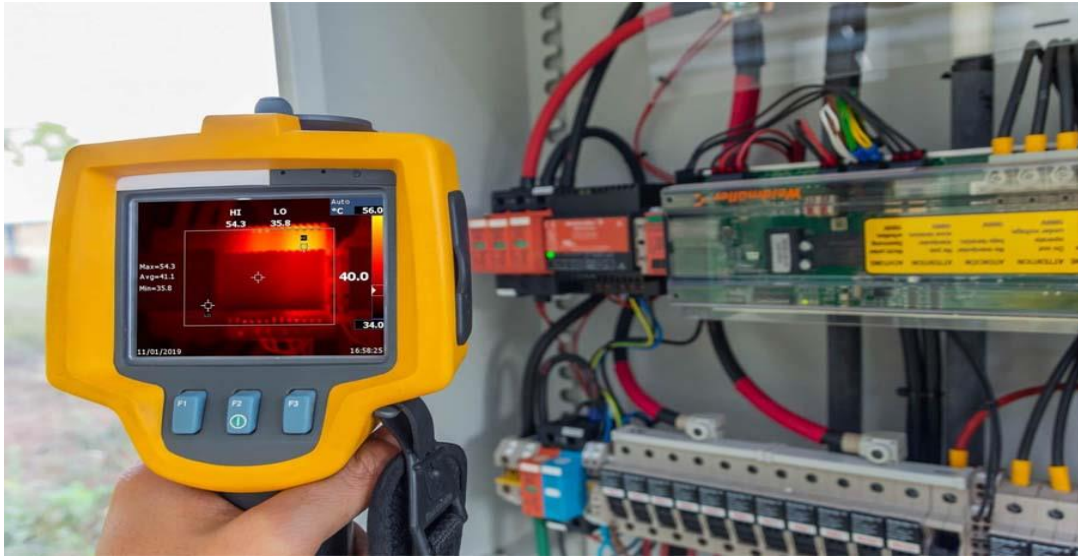
Figura 5: Aplicação Termográfica Na Indústria
