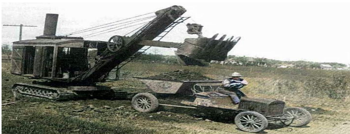
Figura 2 - Ilustração de uma escavadeira a vapor
