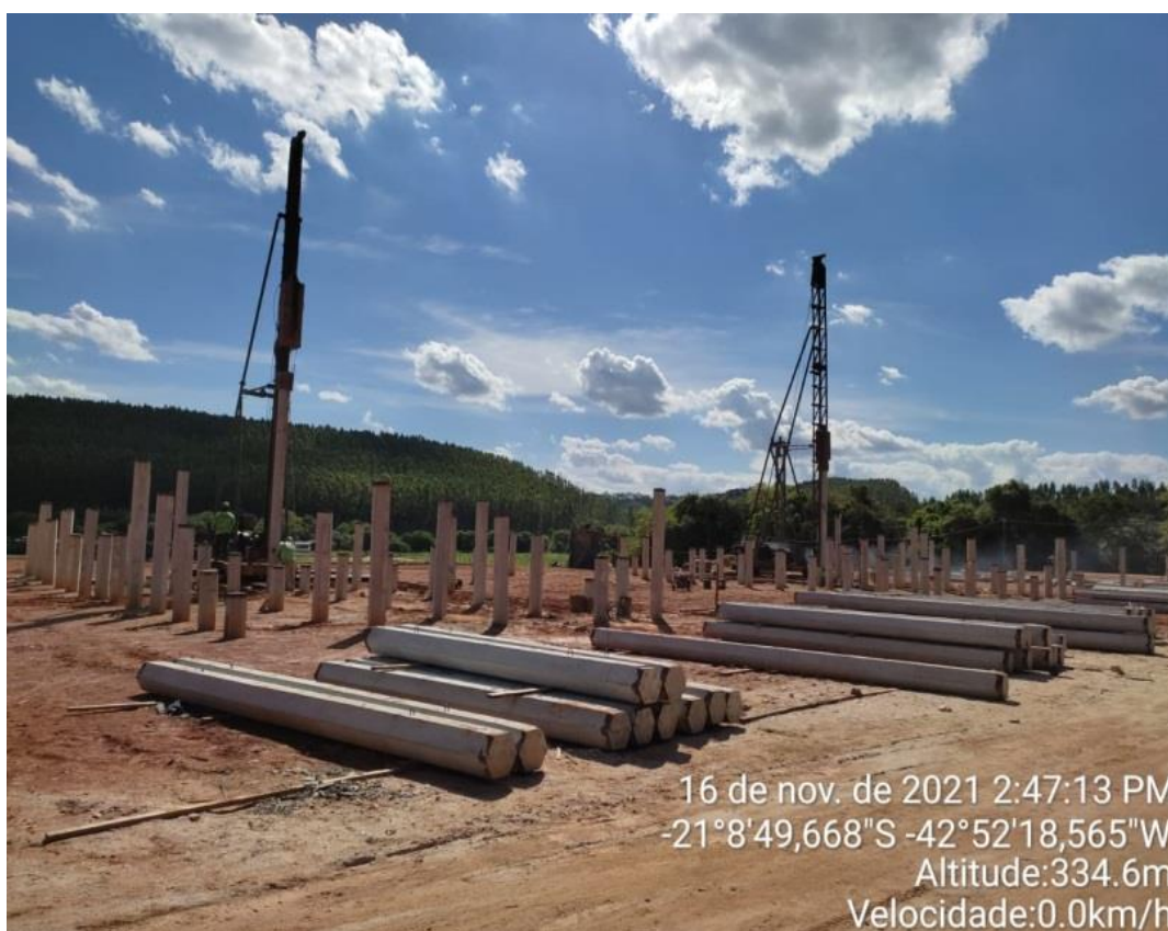
FIGURA 22 – Bate estacas, equipamento de cravamento das estacas
