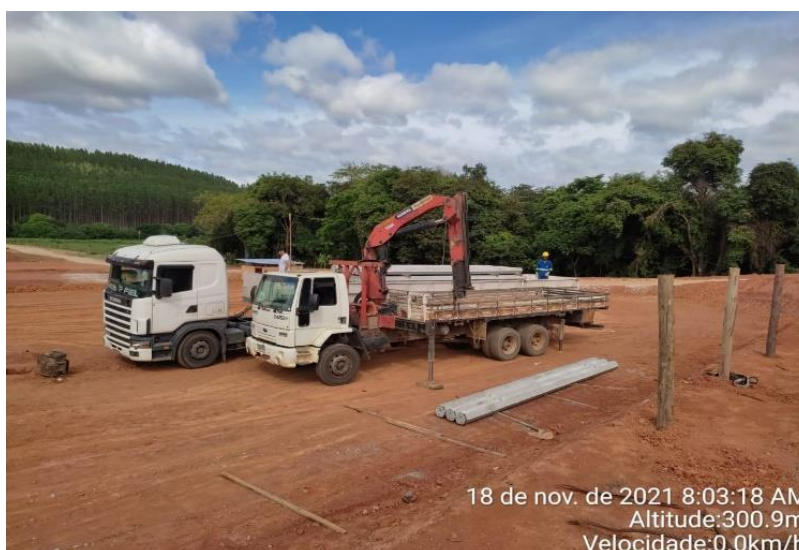
FIGURA 20 – Descarga das estacas pela Ubá Guindaste e Transporte-Ltda MG
