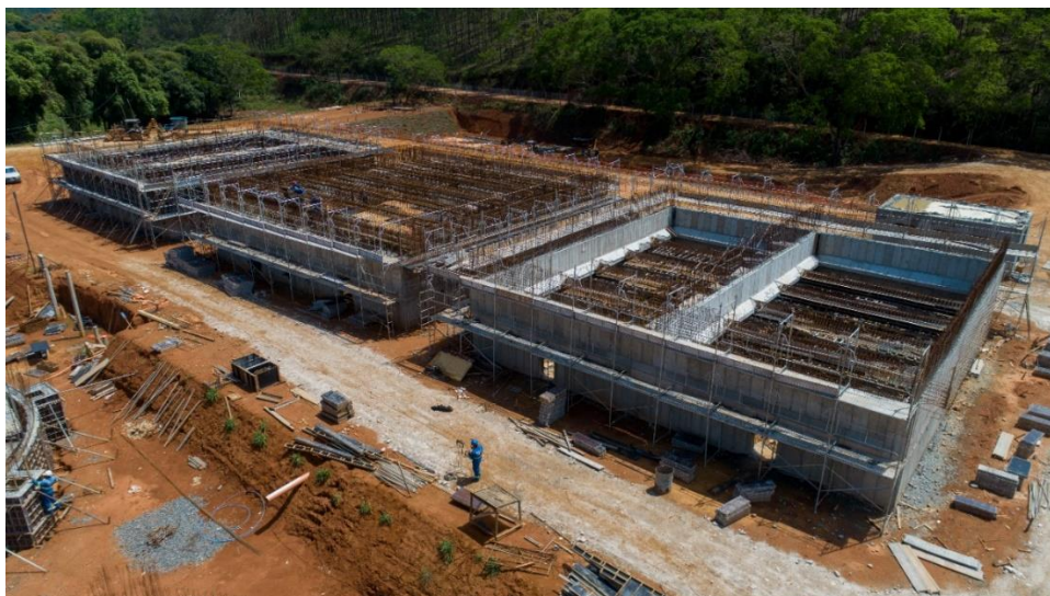
FIGURA 1 – Reatores Anaeróbios da ETE Ubá- MG em construção
