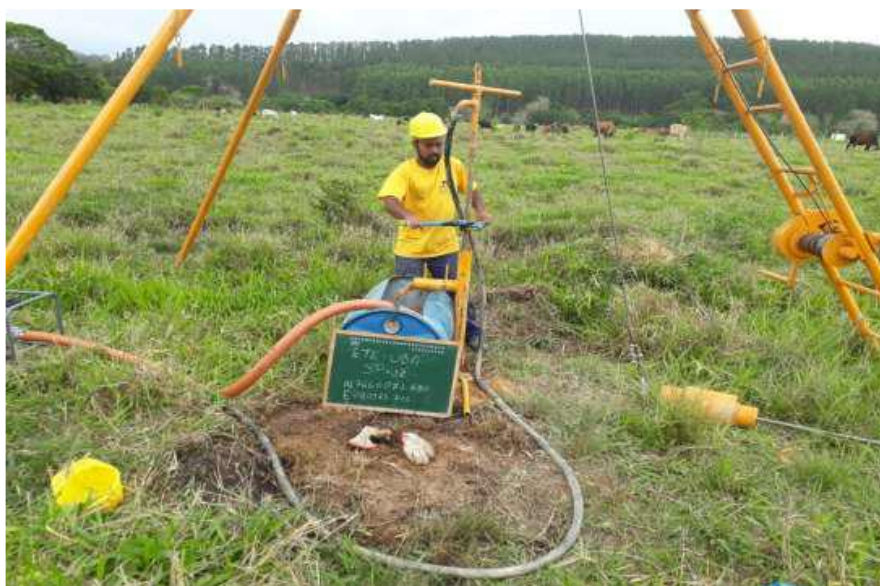
FIGURA 9 – Processo de perfuração das sondagens dos reatores anaeróbios de manto de lodo (UASB)
