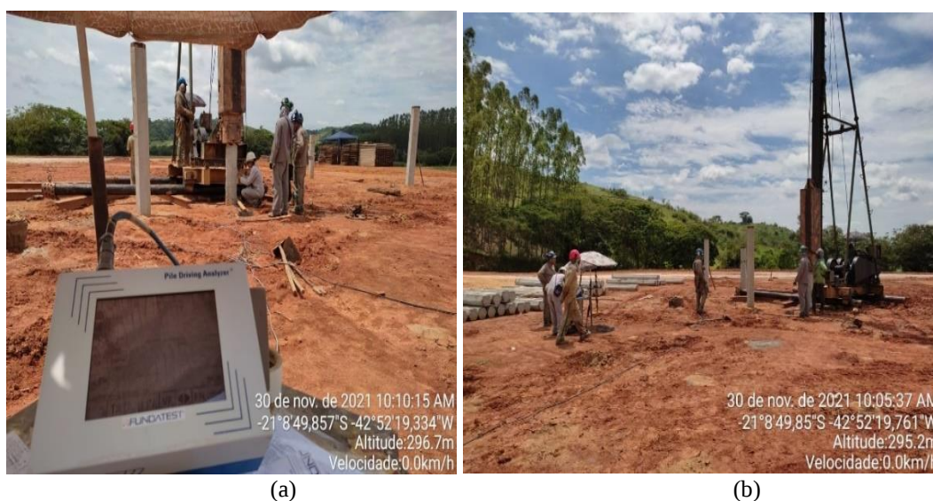
FIGURA 25 – Ensaio de carregamento dinâmico (PDA) nas estacas P31 dos reatores anaeróbios de manto de lodo (UASB) (a e b)
