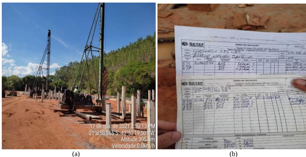
FIGURA 23 – Execução de cravamento das estacas (a) diário de cravação das estacas P31 nos reatores anaeróbios de manto de lodo (UASB)
