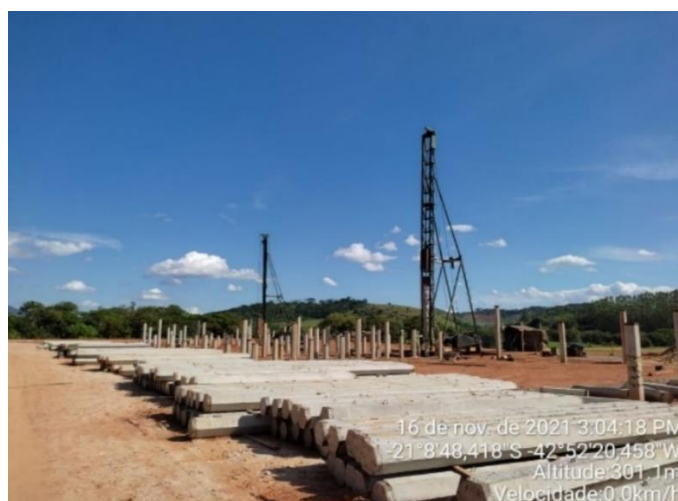
FIGURA 24 – Finalização do cravamento das estacas P31 dos reatores anaeróbios de manto de lodo (UASB)
