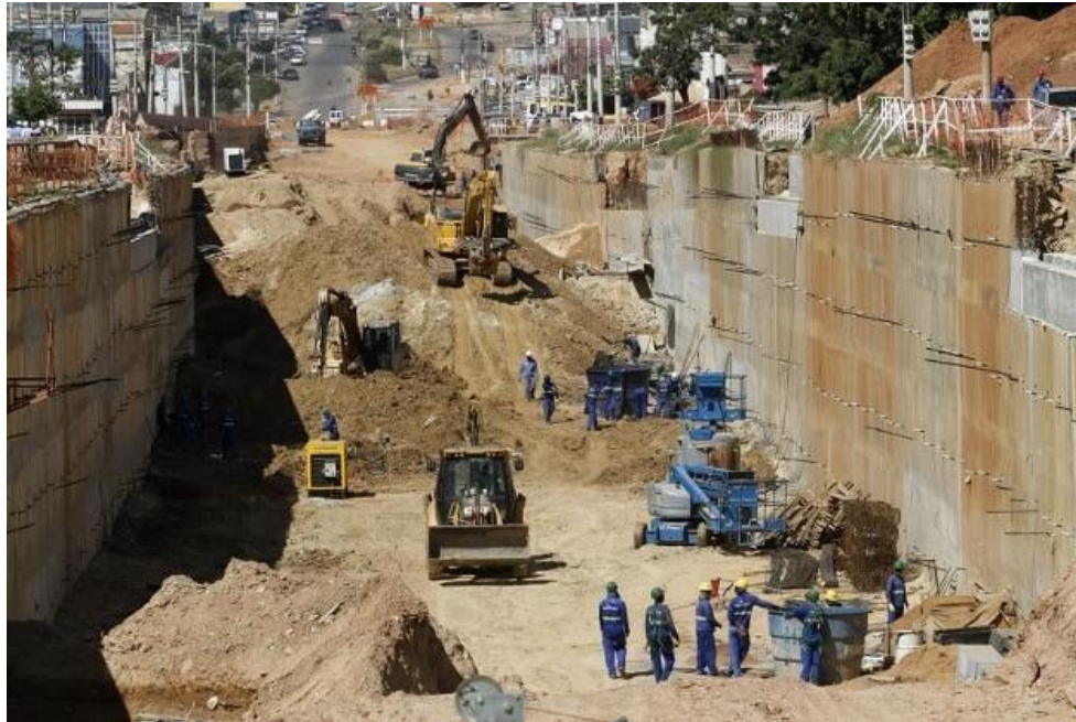
Figura 3 – Canteiro de obra no formato longo e estreito
