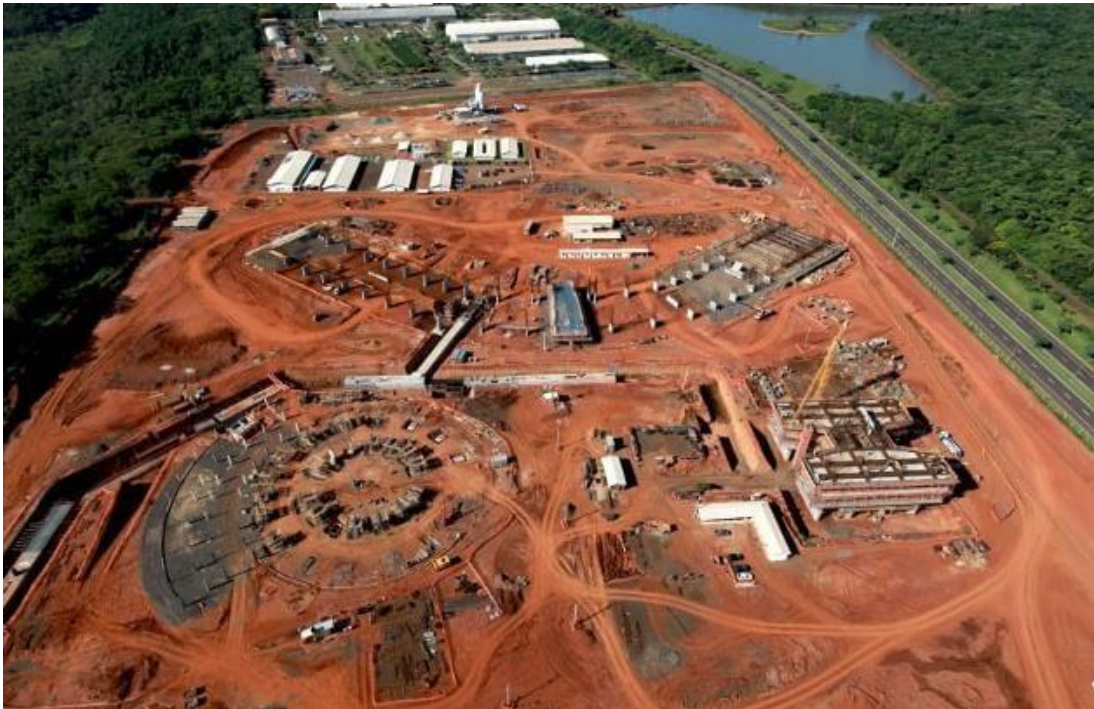
Figura 2 – Canteiro de obras amplo
