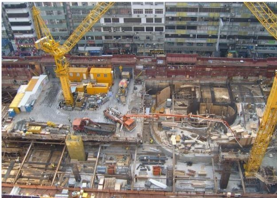
Figura 1 – Canteiro de obras restrito
