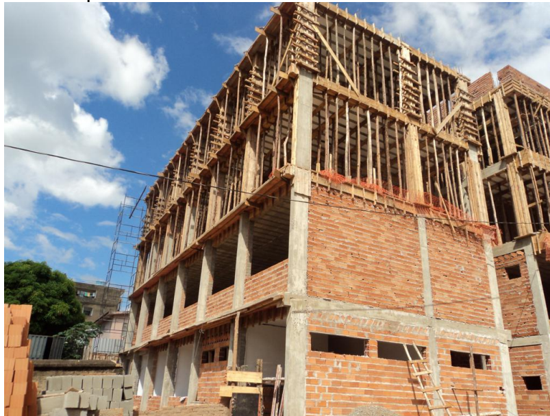
Figura 1: Exemplo de alvenaria convencional com bloco de cerâmicas.
