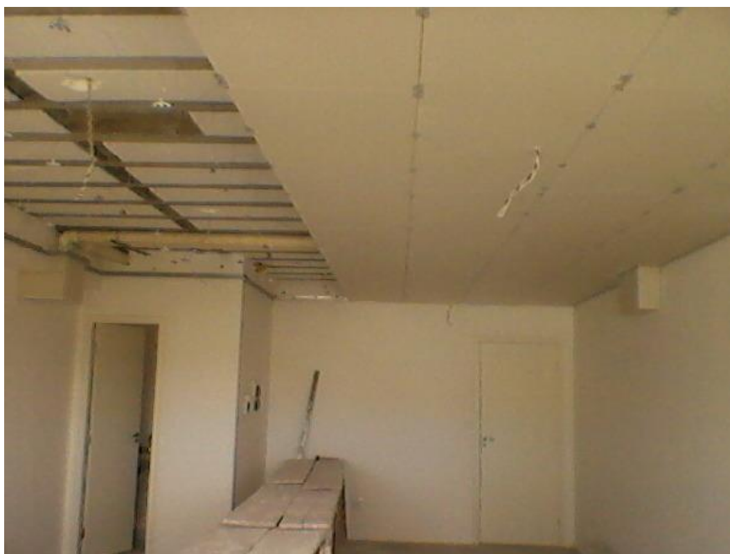
Figura 14 – Instalação de forro de gesso acartonado abaixo das lajes treliçadas
