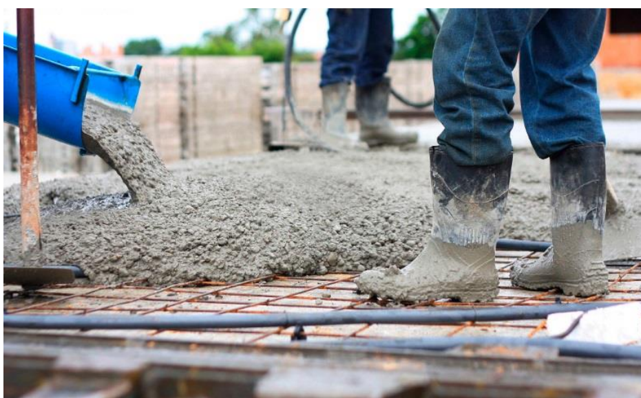
Figura 13 – Concretagem
