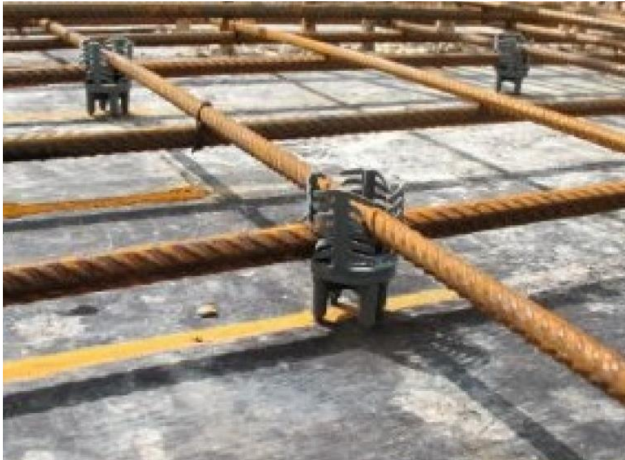
Figura 3B – Colocação dos espaçadores
