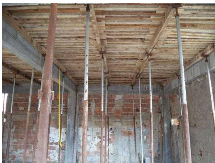
Figura 2 – Alocação das fôrmas e escoramento
