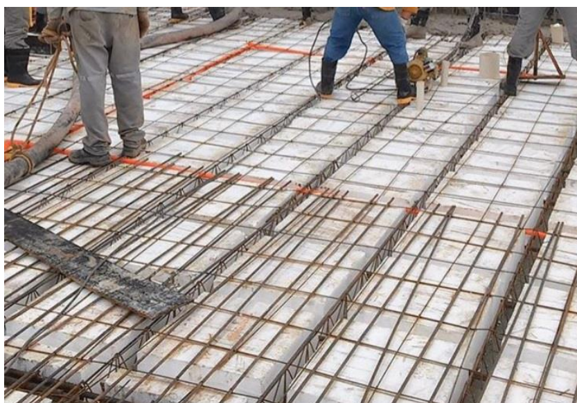
Figura 12 – Posicionamento de armaduras negativas
