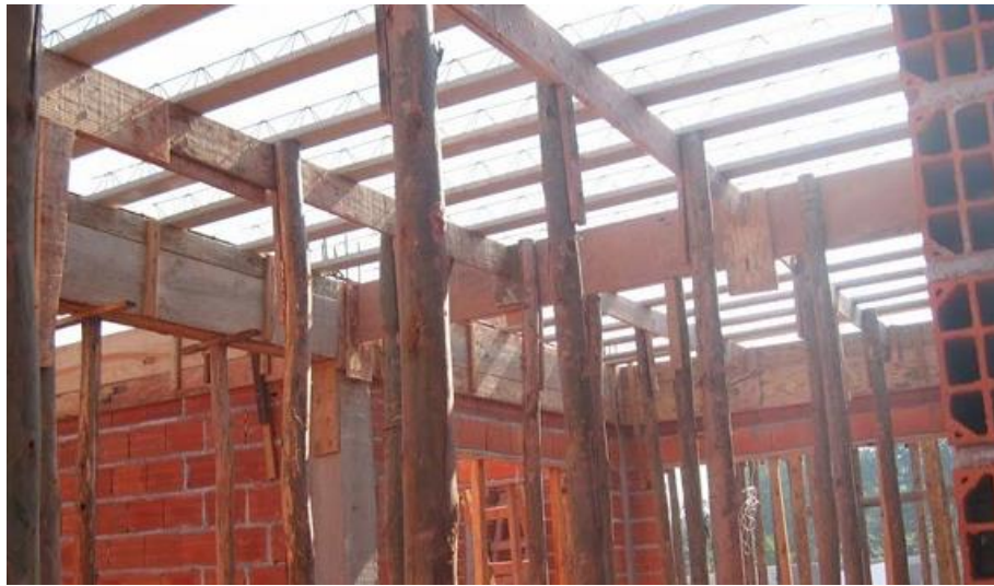
Figura 9 – Montagem das vigotas
