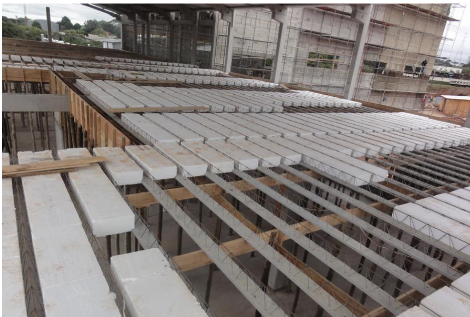
Figura 10 – Preenchimento com placas de EPS
