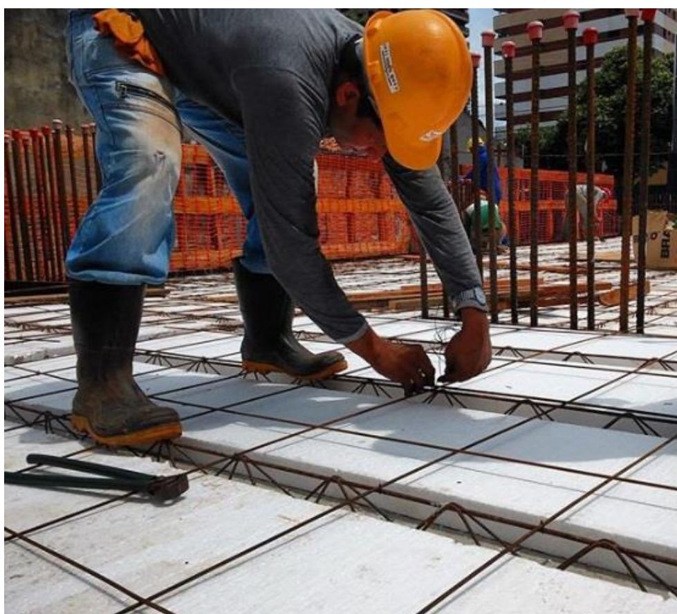
Figura 11 – Posicionamento de armaduras
