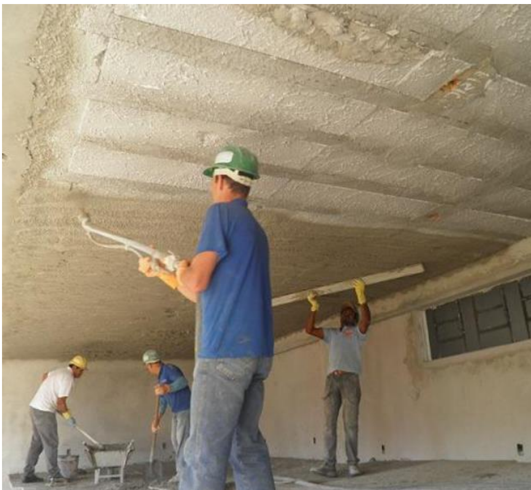
Figura 15 – Aplicação de argamassa projetada nas lajes treliçadas
