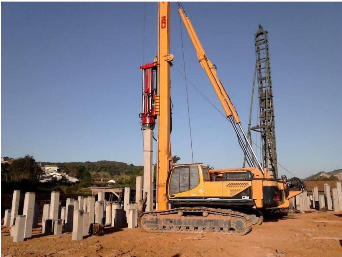
Figura 3 - Cravação utilizando bate-estaca
