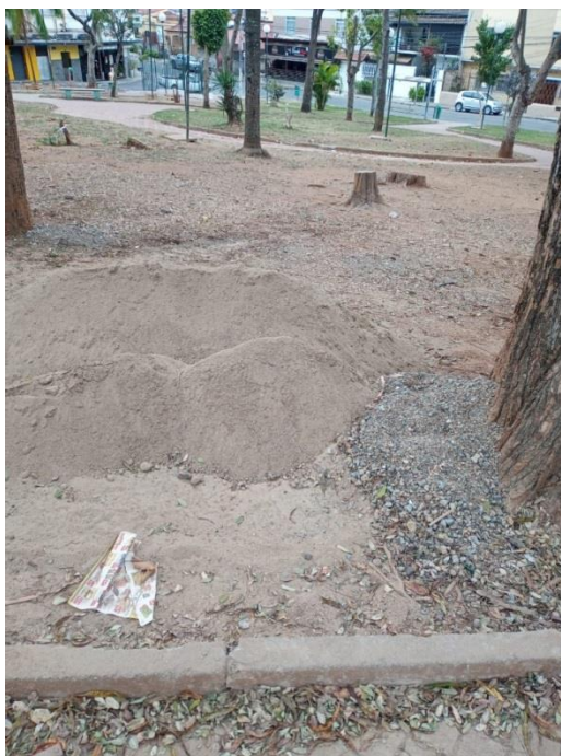
Figura 6 – Materiais de obra, como areia, brita, árvores cortadas e lixos em praça urbana de Juiz de Fora, em estudo de agosto a dezembro de 2022. Fonte: Arquivo pessoal, 2022.
