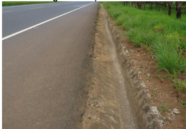
Figura 6: Sarjeta de Aterro
