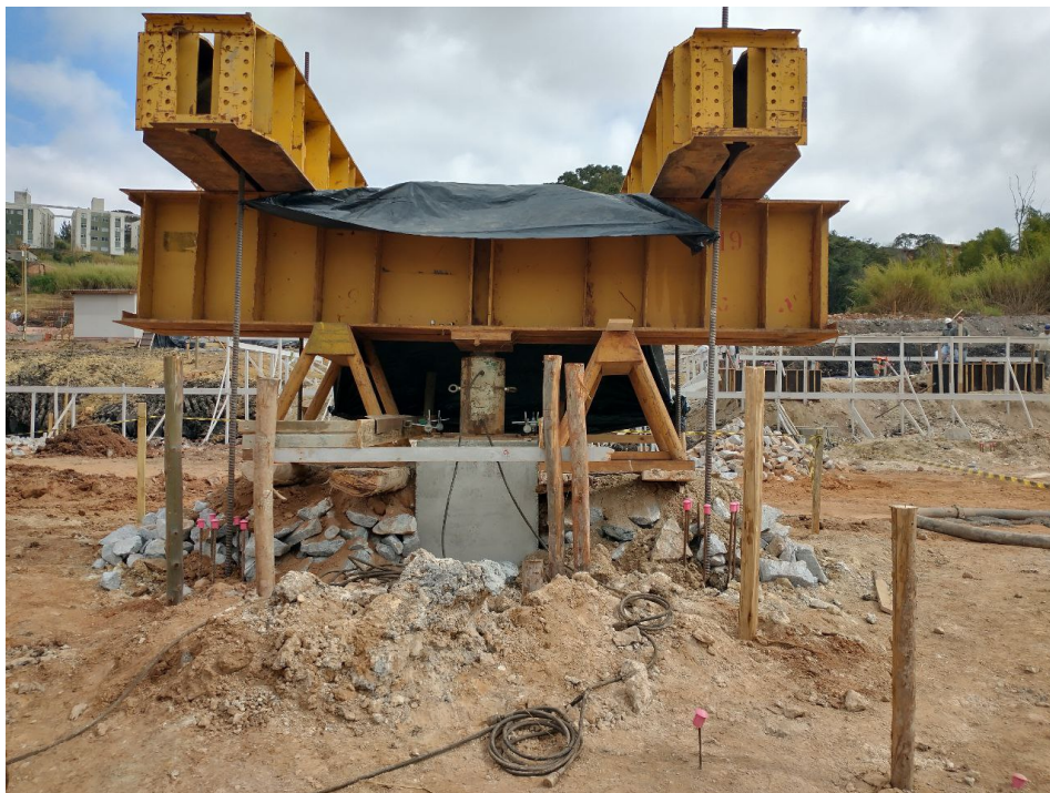
Figura 3 – Equipamento do sistema de reação totalmente mobilizado.
