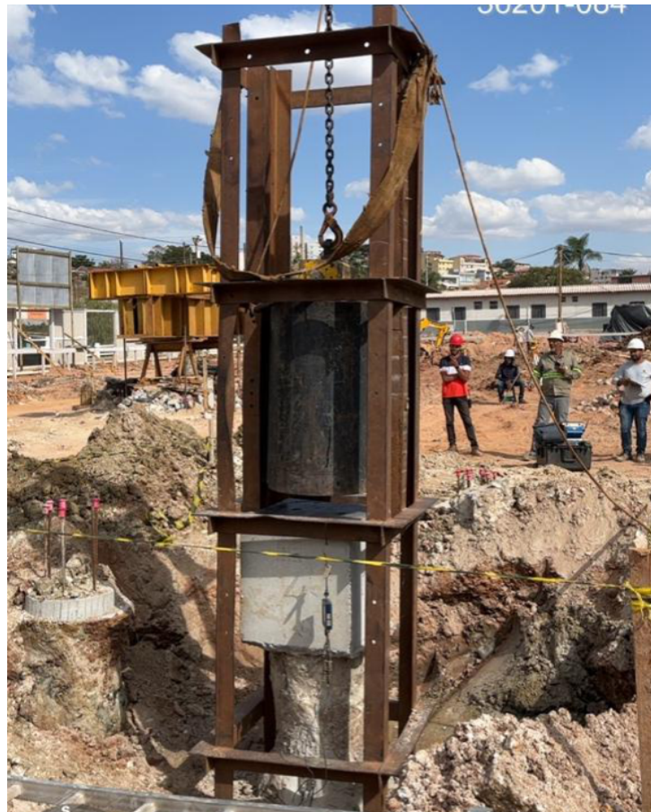
Figura 3 - Equipamento totalmente mobilizado.
