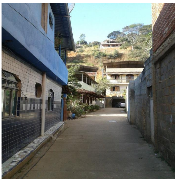
Figura 3: A ausência de calçamento (acesso às casas)
