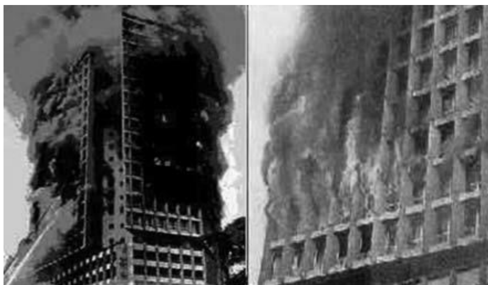
Figura 5 – Incêndio no edifício Joelma.
