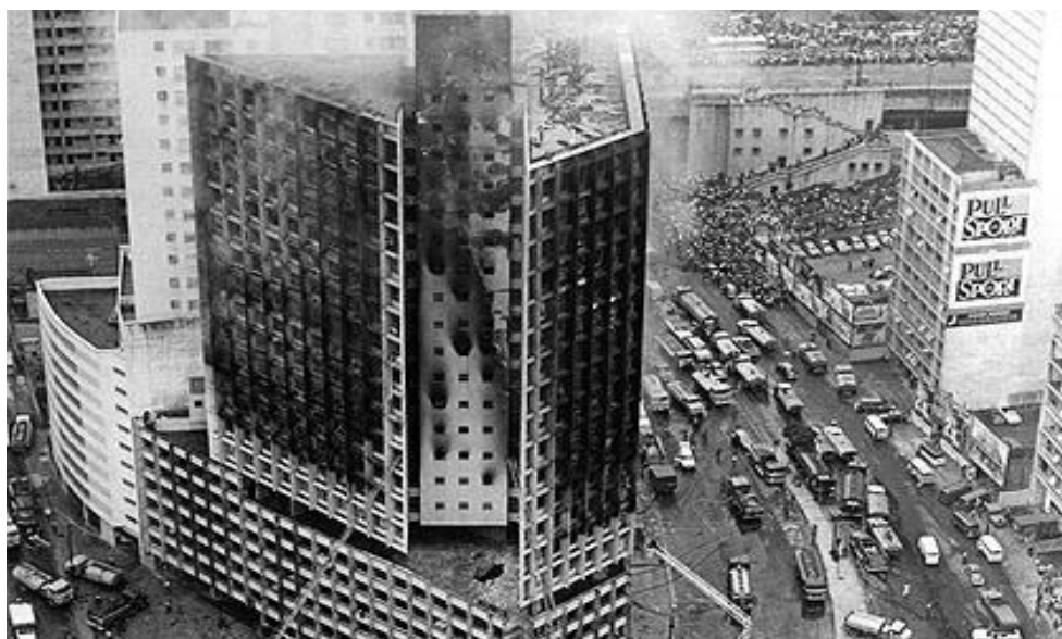
Figura 4 – Incêndio no edifício Andraus em 24 de fevereiro de 1972.
