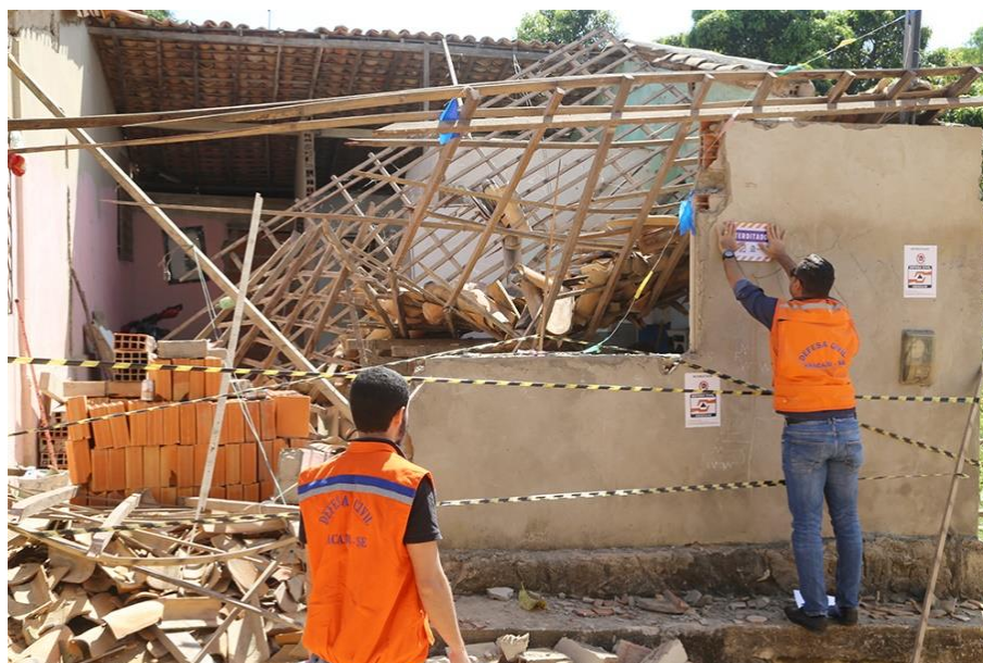
Figura 3 - Seção Insuficiente
