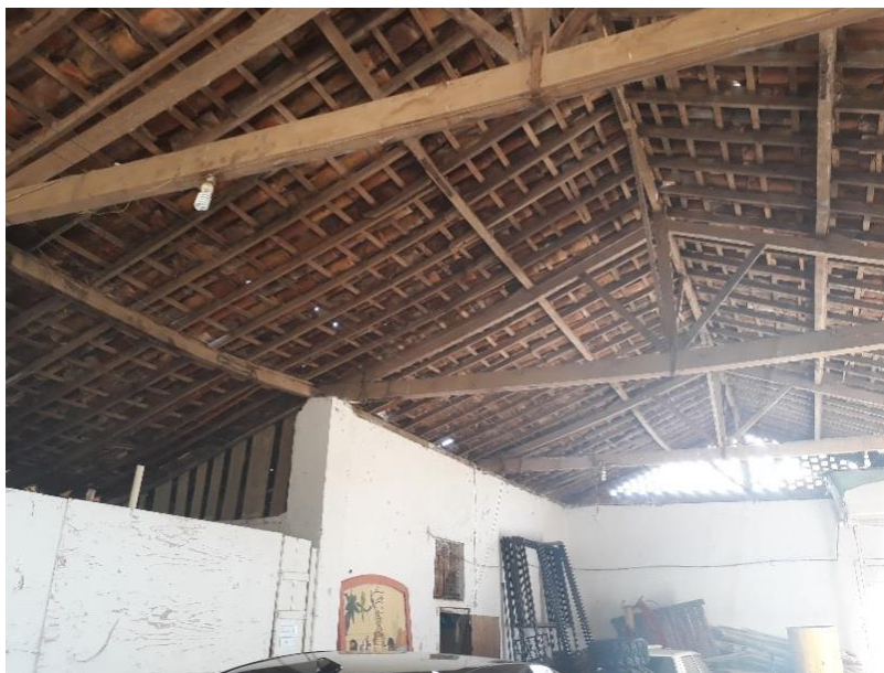
Figura 19 - Reforço dos encaixes por meio de chapas metálicas
