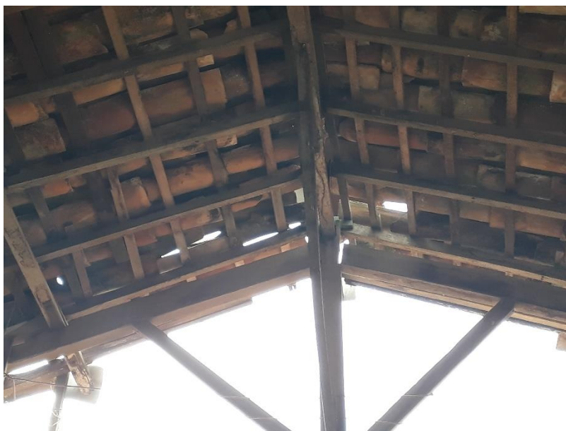
Figura 20 - Encaixe com Necessidade Imediata de Reforço
