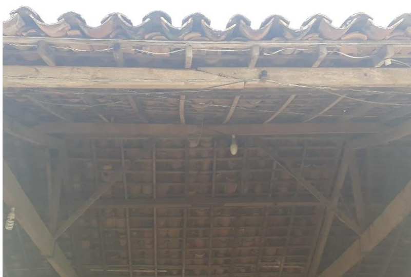
Figura 17 - Ausência de Bonecas nas Escoras
