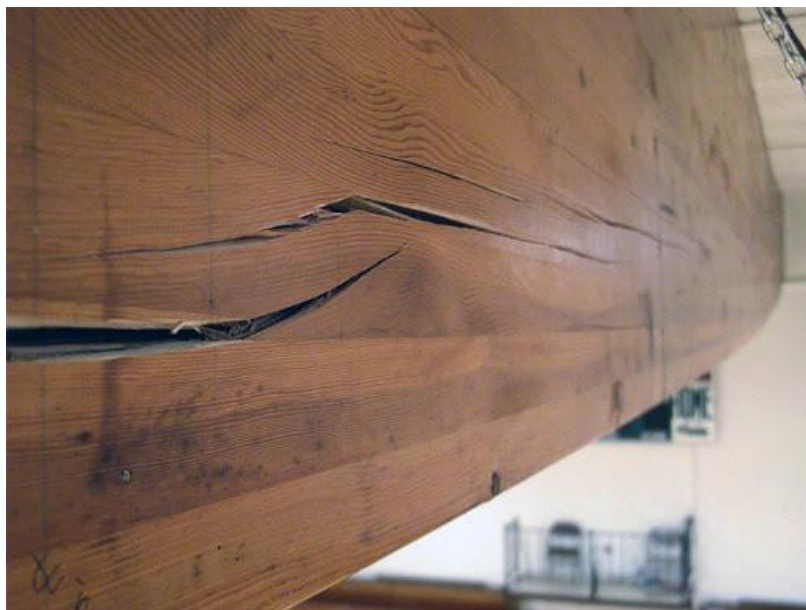
Figura 2 - Fenda Longitudinal
