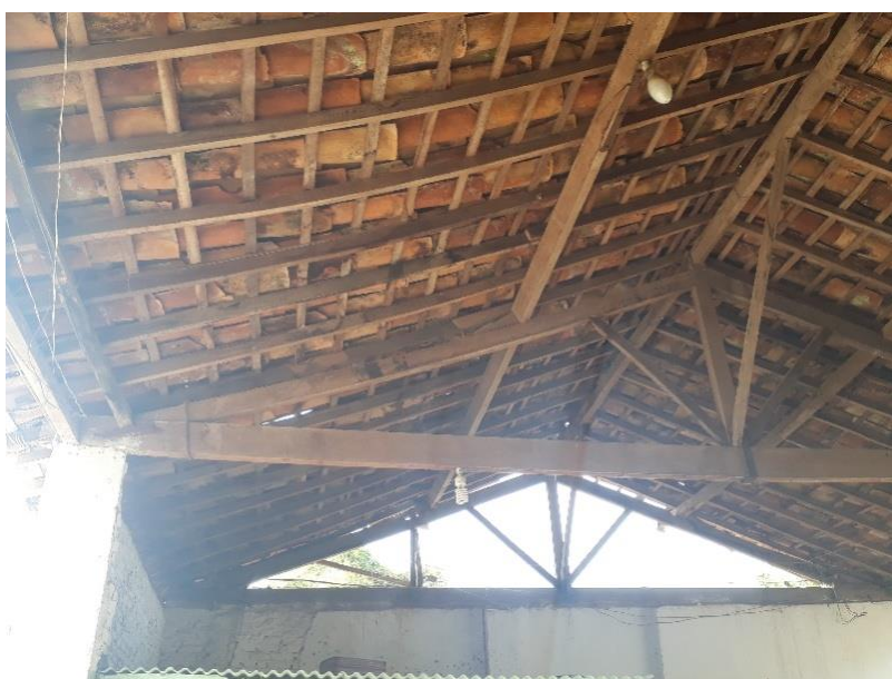
Figura 17 - Ausência de Bonecas nas Escoras
