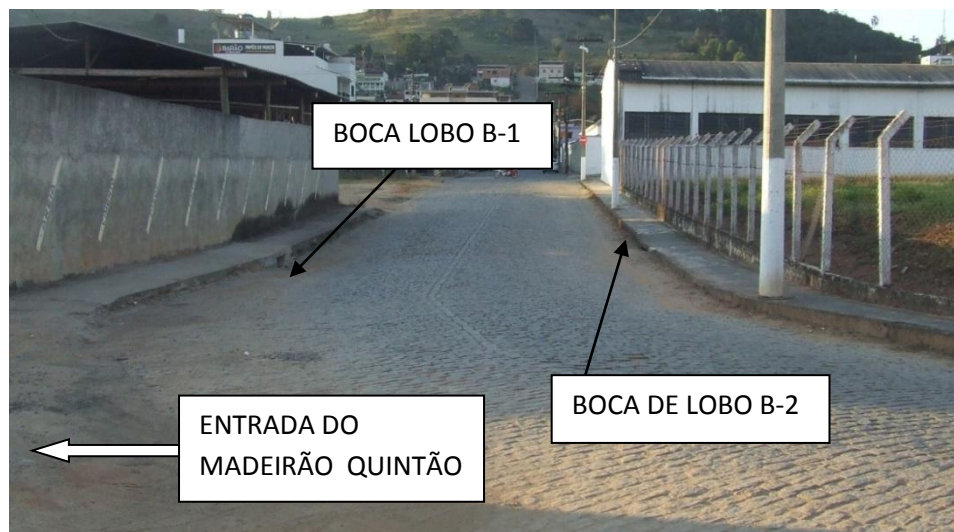
FIGURA 6 – Localização das bocas de lobo
