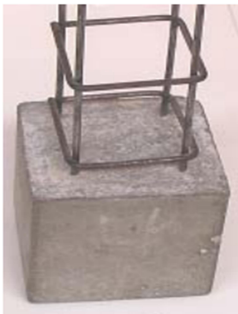
Figura 6 - Pilar parcialmente concretado.
