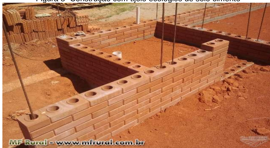
Figura 8- Construção com tijolo ecológico de solo cimento
