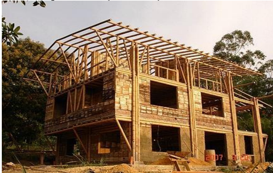
Figura 2- Construção de edificação à base de bambu
