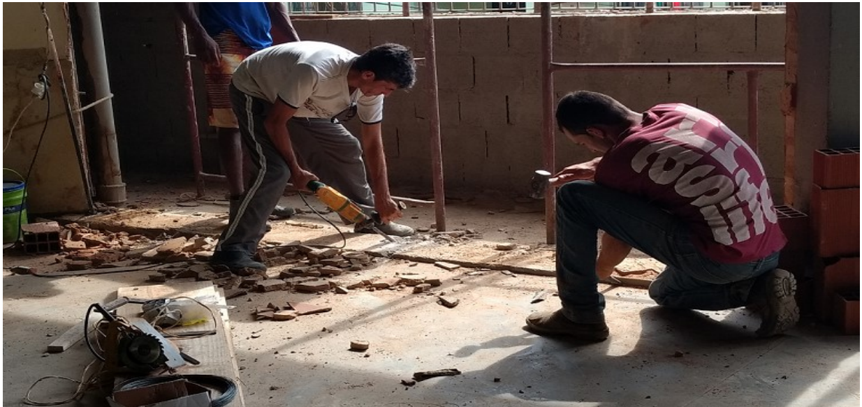
Figura 02 – Serventes quebrando piso de concreto.
