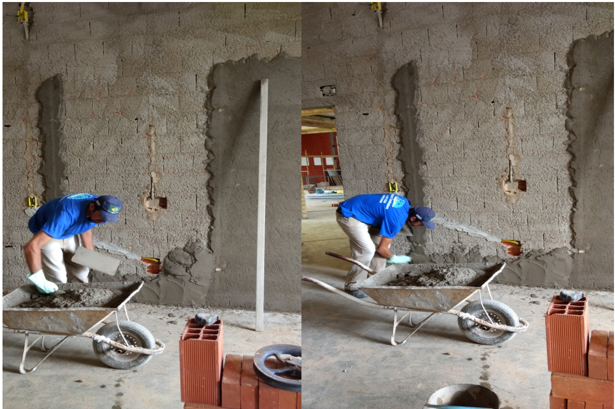
Figura 01 – Servente realizando reboco na parte baixa da parede.
