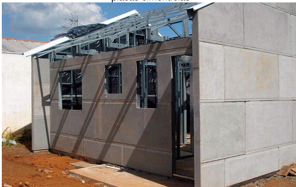
Figura 27 – Fechamento externo de uma construção em LSF com a utilização de placas cimentícias
