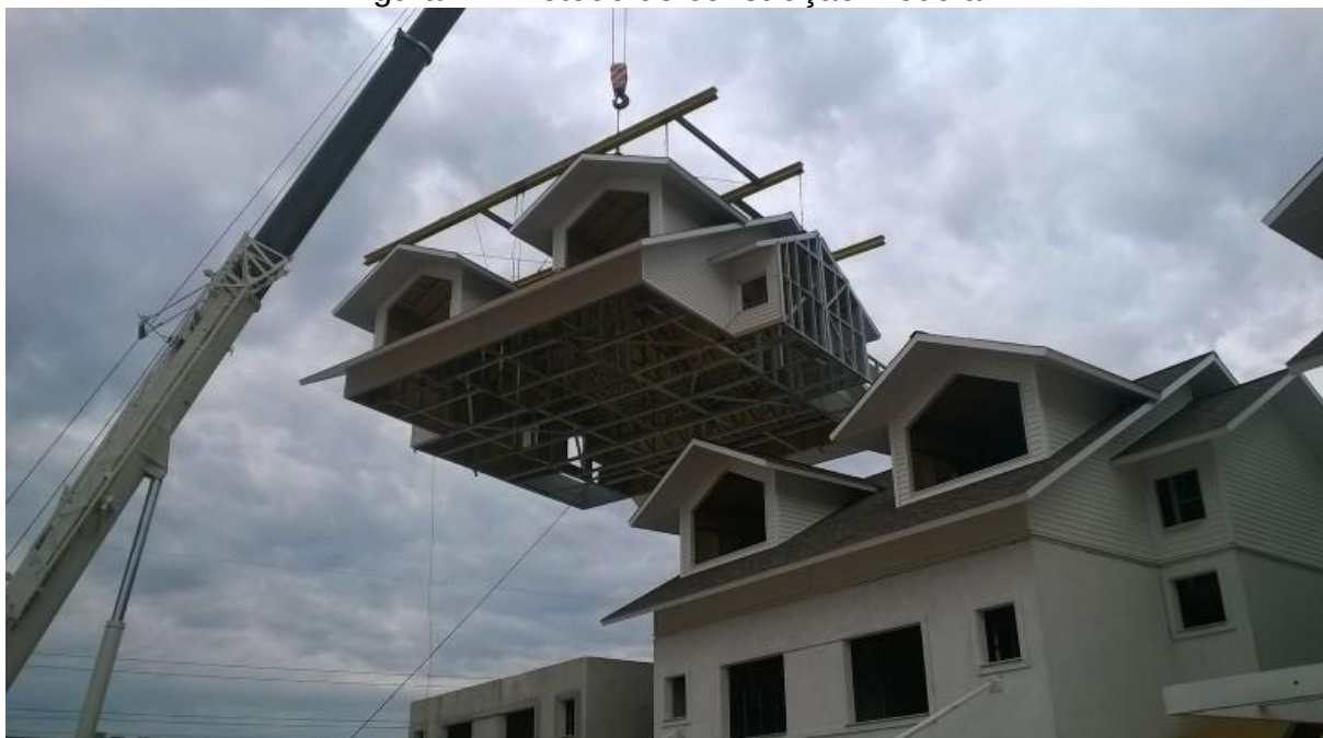
Figura 7 – Método de construção modular
