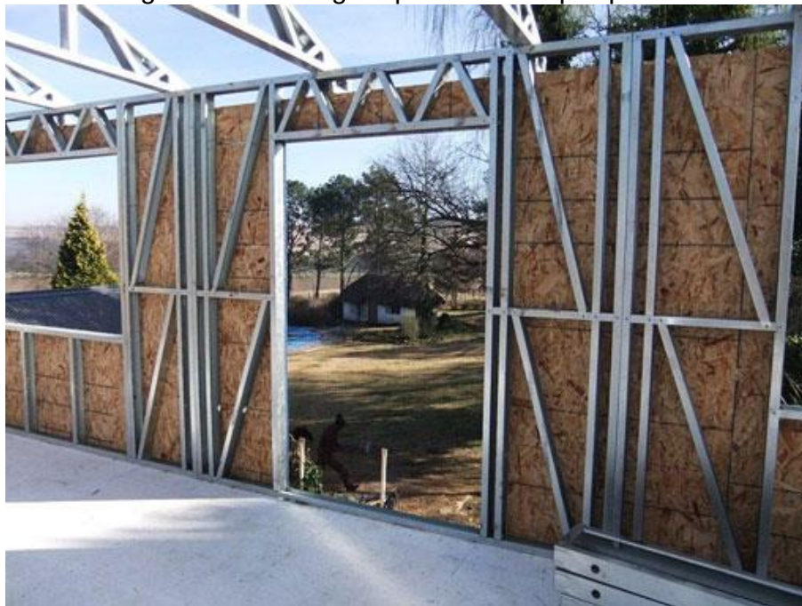
Figura 6 – Montagem pelo método por painéis
