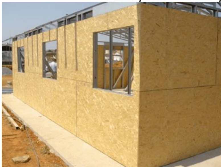
Figura 24 – Placas OSB constituindo a vedação de uma construção em LSF
