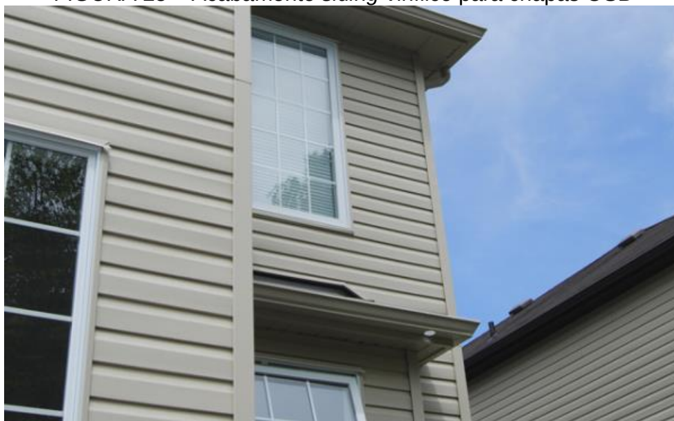
FIGURA 25 – Acabamento siding vinílico para chapas OSB
