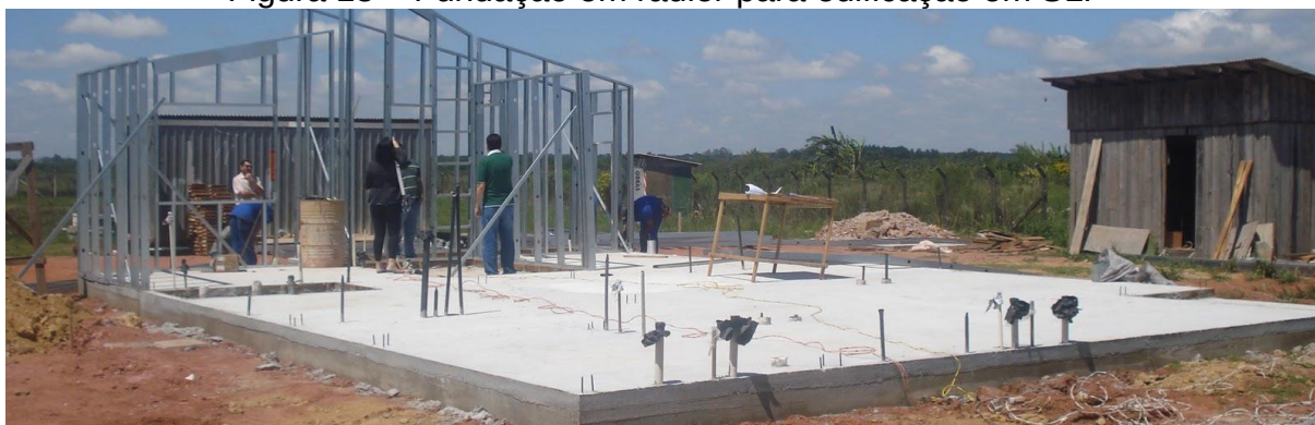
Figura 13 – Fundação em radier para edificação em SLF
