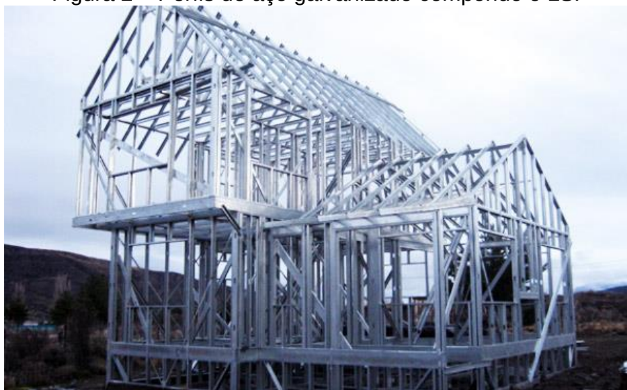
Figura 2 – Perfis de aço galvanizado compondo o LSF
