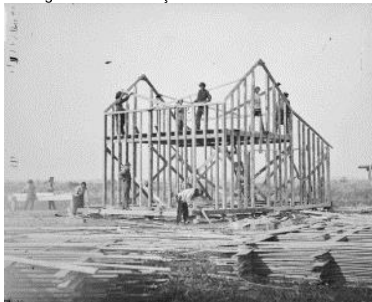
Figura 1 – Construção em frames de madeira
