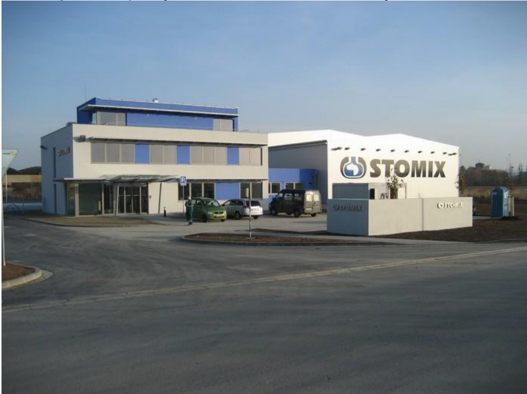
Figura 8 - Aplicação do sistema LSF em edificação comercial.
