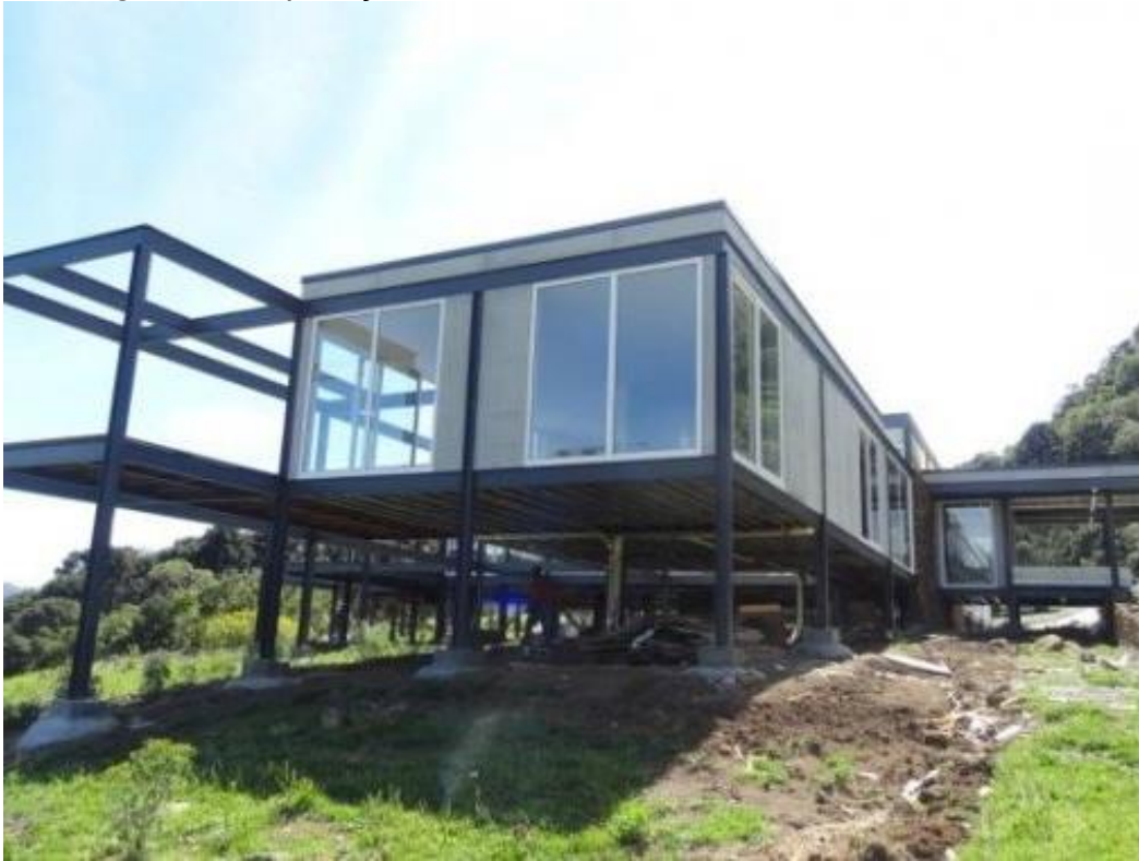
Figura 10 - Aplicação do sistema LSF em residência unifamiliar
