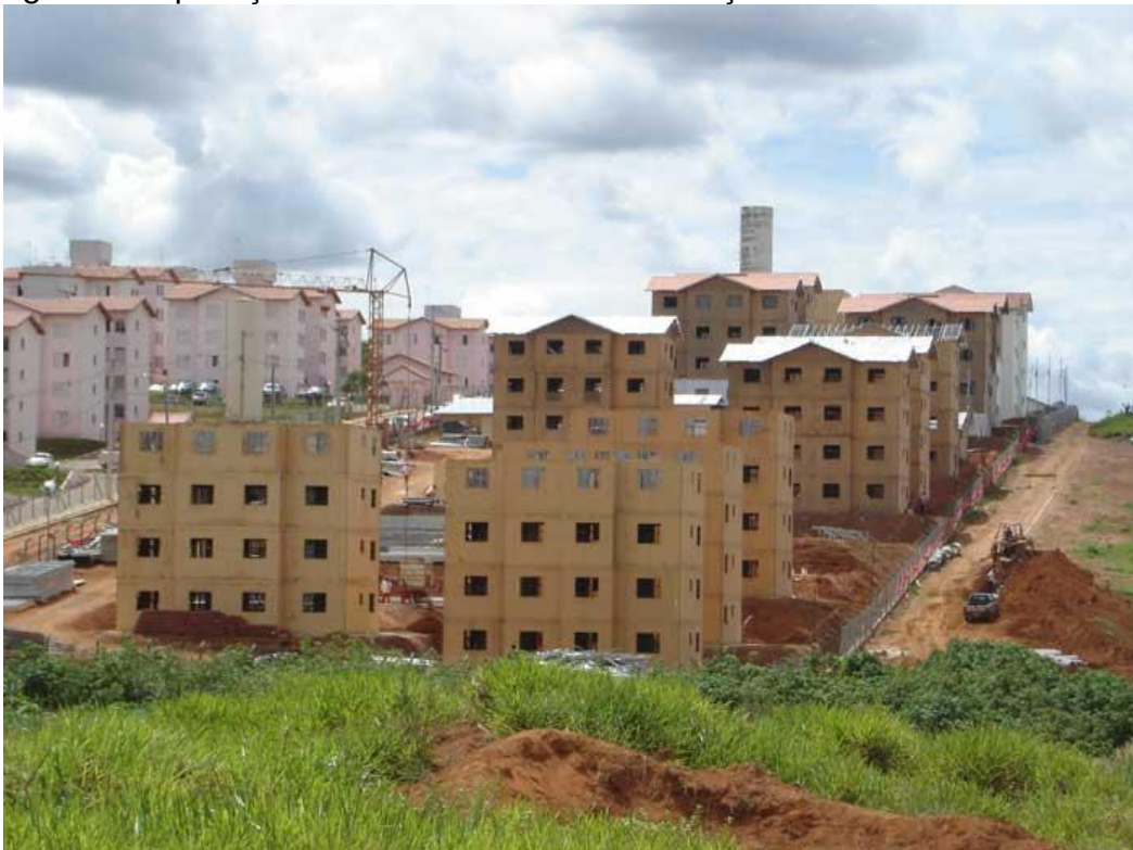
Figura 9 - Aplicação do sistema LSF em edificação residencial multifamiliar
