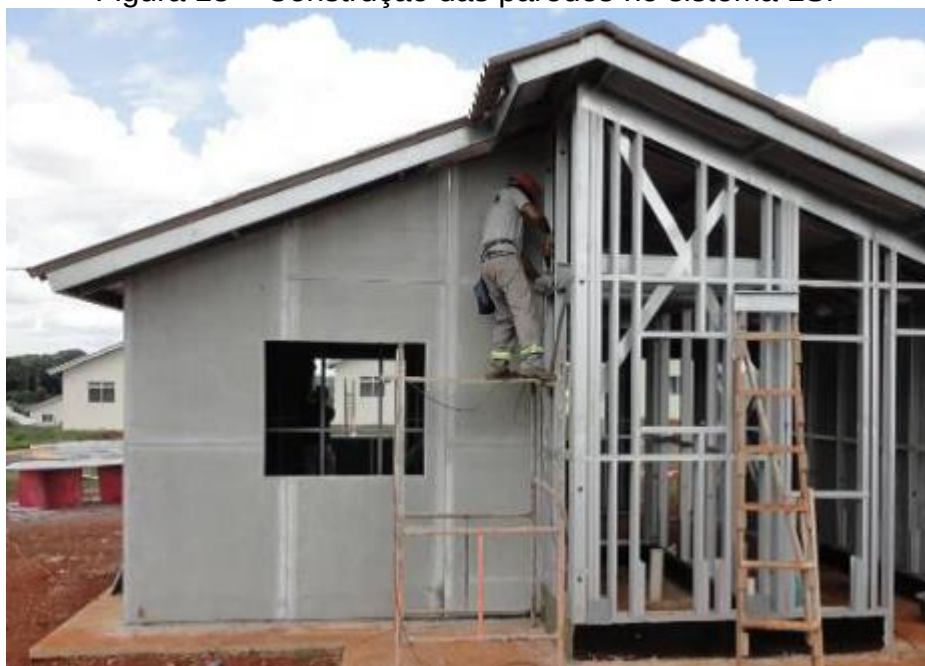
Figura 18 – Construção das paredes no sistema LSF
