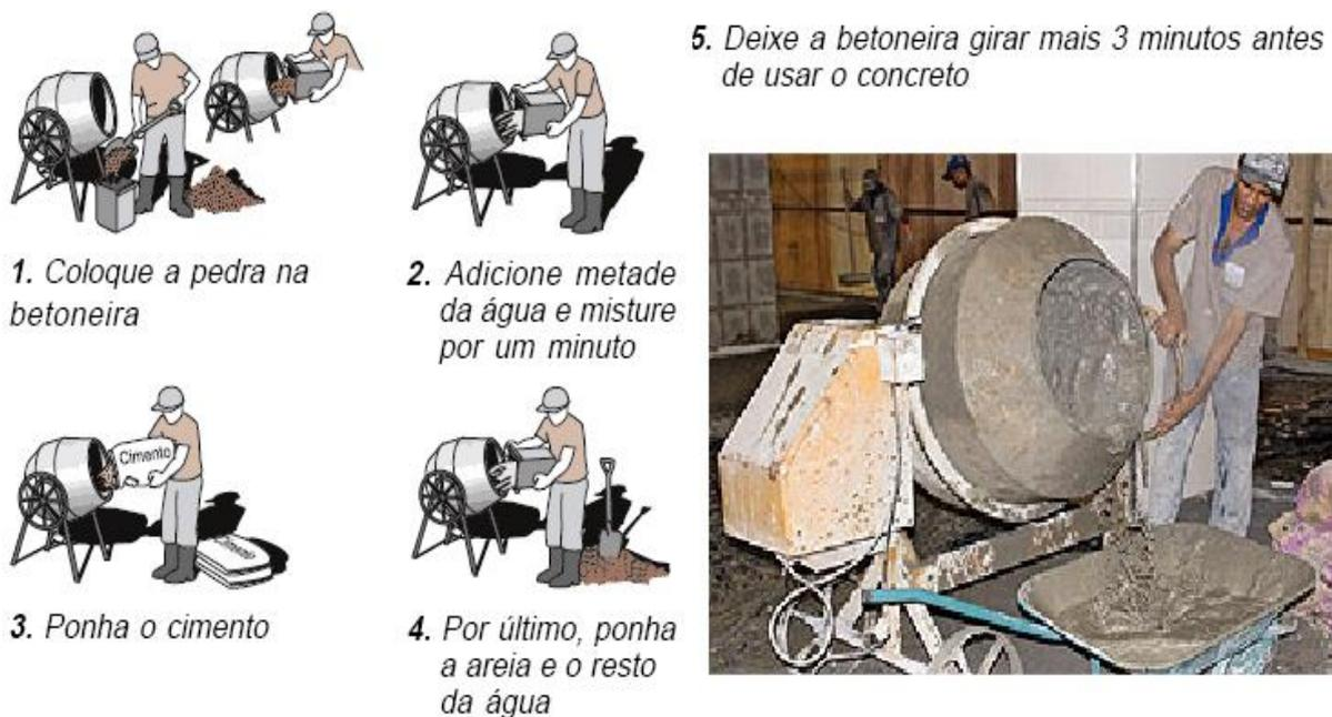
Figura 1 – procedimento do concreto realizado na betoneira.
