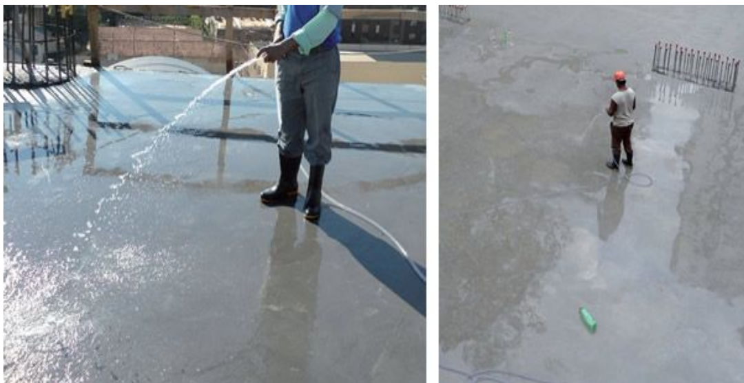
Figura 16: Concretagem e Regularização.
