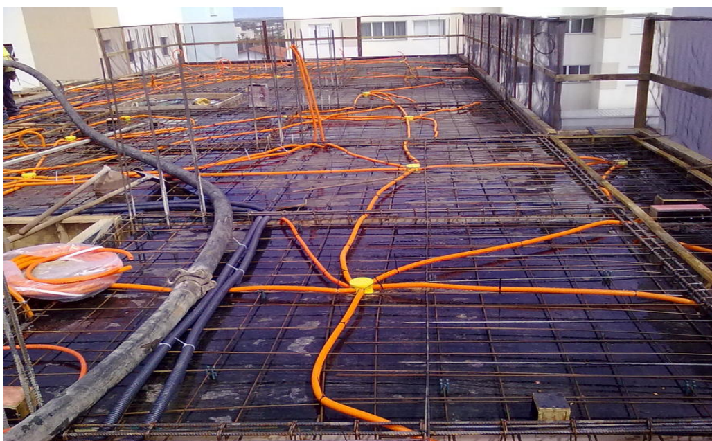
Figura 20: Instalação de eletrodutos, tubos e caixas.
