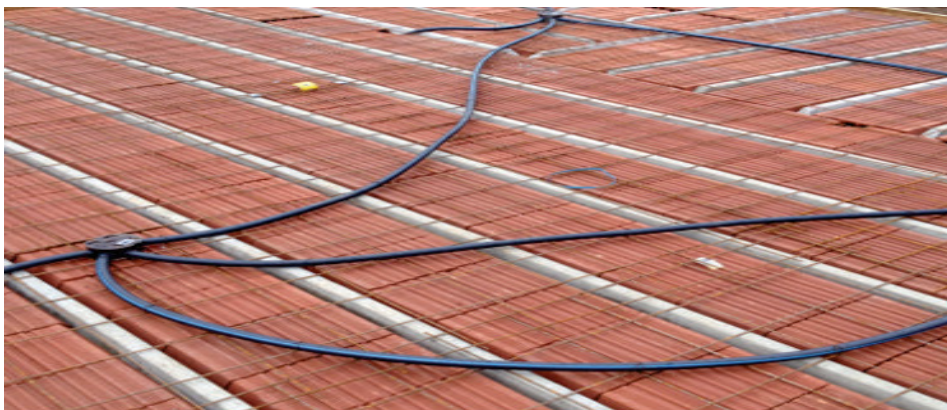
Figura 14: Colocação de aço sobre as vigotas e tabelas.
