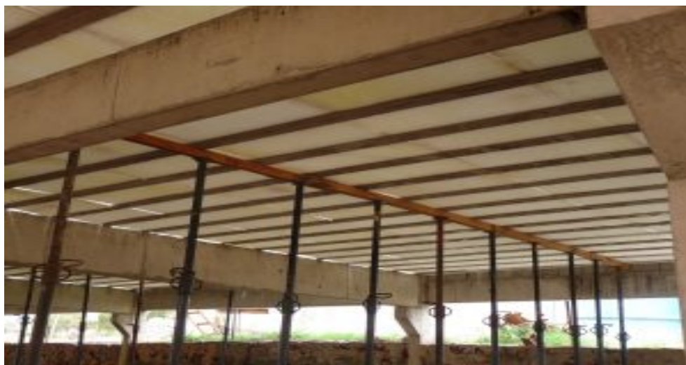
Figura 13: Instalação das vigotas com escoramento.
