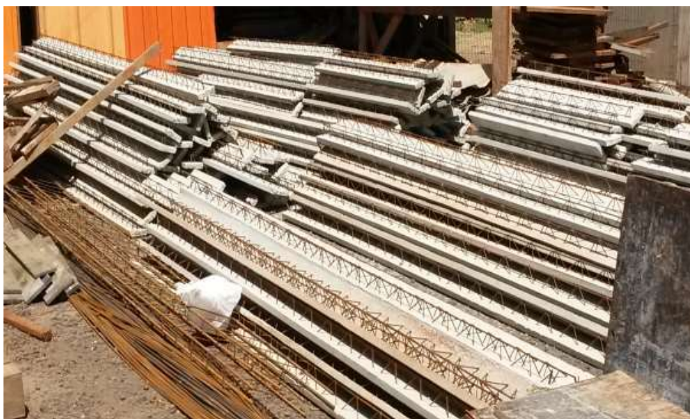
Figura 12: Vigotas Pré-fabricadas.
