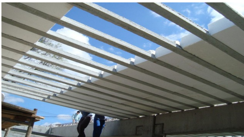
Figura 11: Laje de vigotas pré-fabricada.
