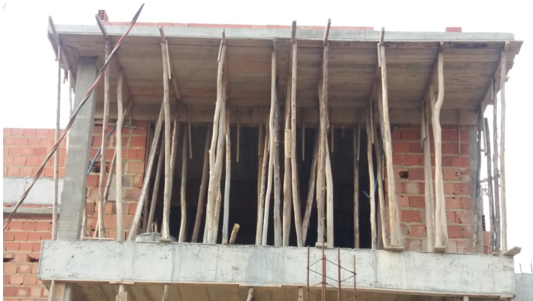
Figura 18: Colocação das escoras de madeira
