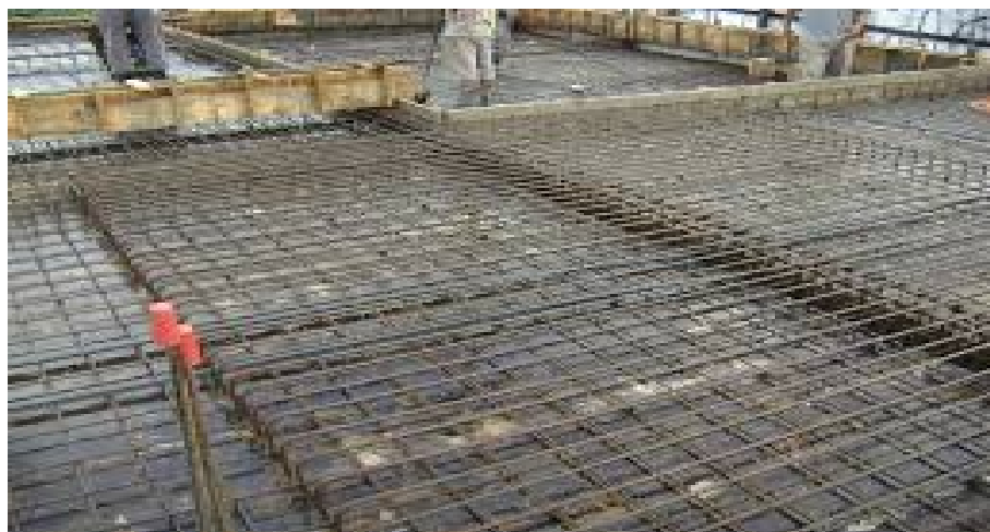
Figura 19: Colocação da armadura de aço.
