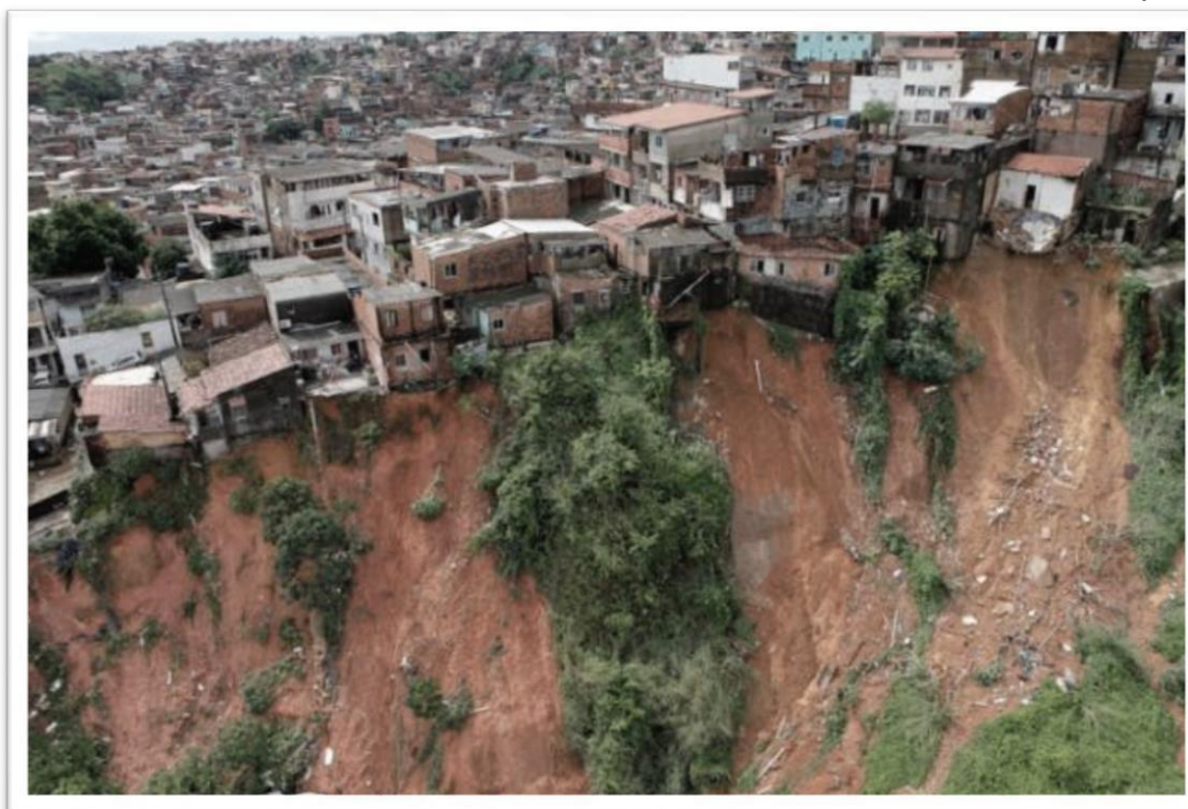
FIGURA 12 – Deslizamento de terra em encostas desordenadamente ocupadas
