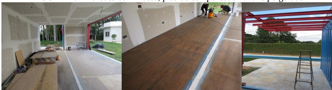
FIGURA 20 – Paredes com massa, piso de compensado naval e pergolado
