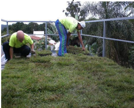
FIGURA 11 – Instalação do telhado verde
