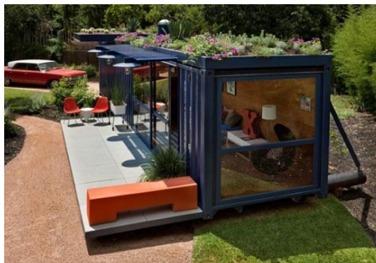
FIGURA 4 – Casa contêiner com telhado verde
