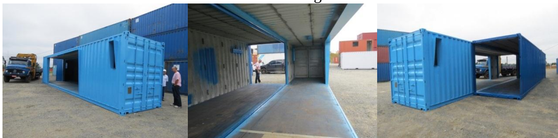
FIGURA 16 – Corte e montagem do contêineres
