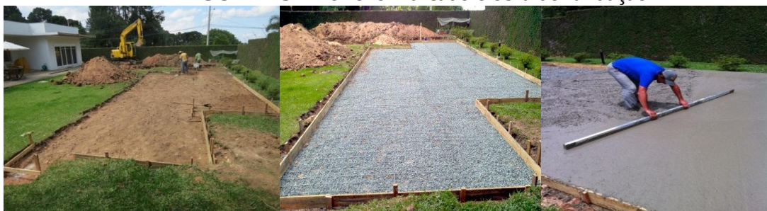
FIGURA 15 – Terreno marcado e obra de fundação
