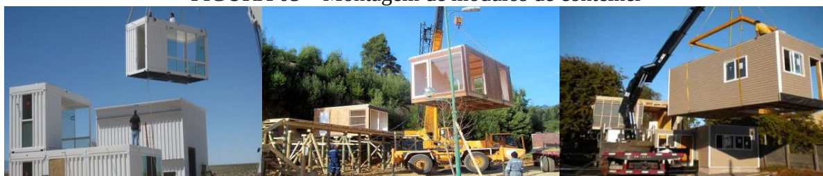
FIGURA 05 – Montagem de módulos de contêiner
