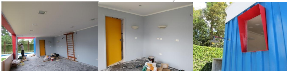
FIGURA 21 – Portas e janela
