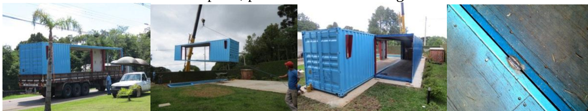
FIGURA 17 – Transporte, posicionamento e soldagem dos contêineres
