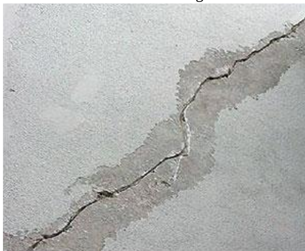
FIGURA 03 – Fissura geométrica
