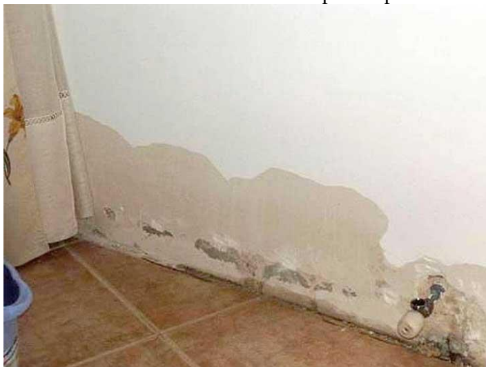
FIGURA 20 – Manchas trazidas pela capilaridade
