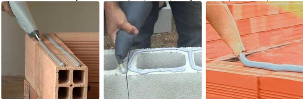
FIGURA 9 – Utilização de bisnagas para aplicação de argamassa polimérica
