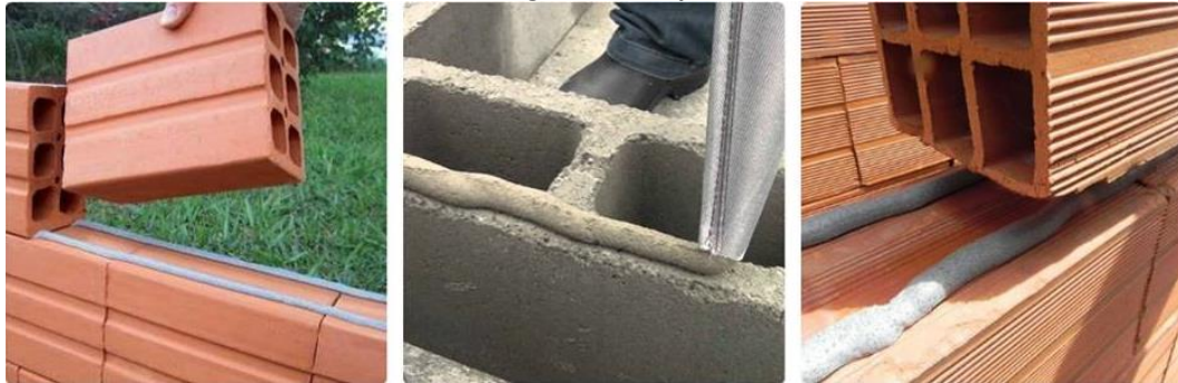
FIGURA 8 – Assentamento de argamassa polimérica com a técnica cordão
