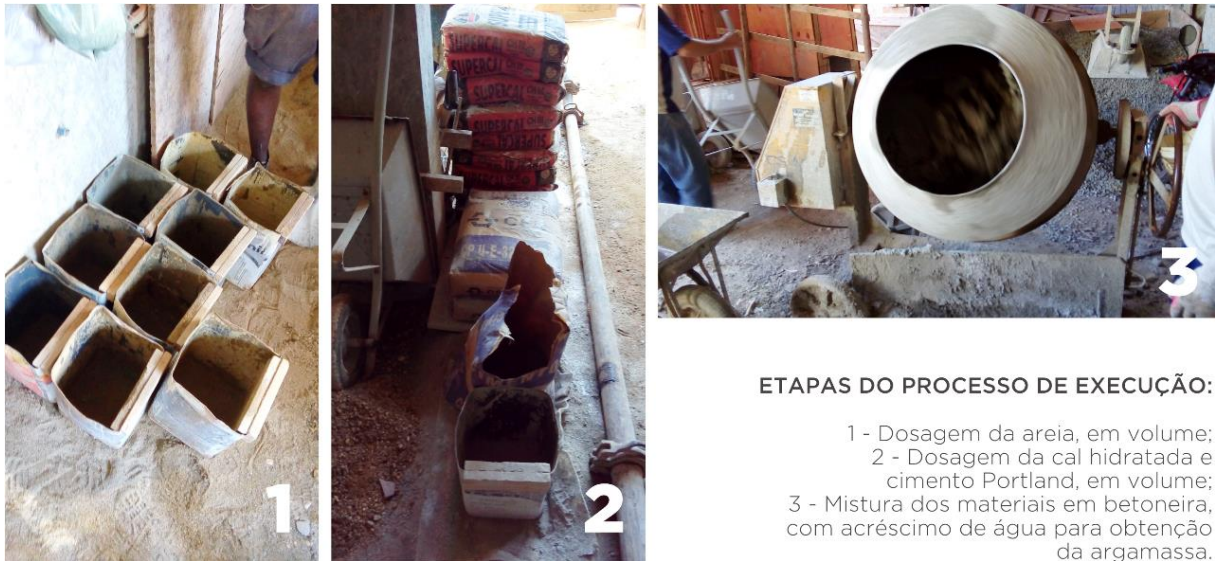
FIGURA 3 – Produção convencional em obra de argamassa para assentamento de alvenaria
