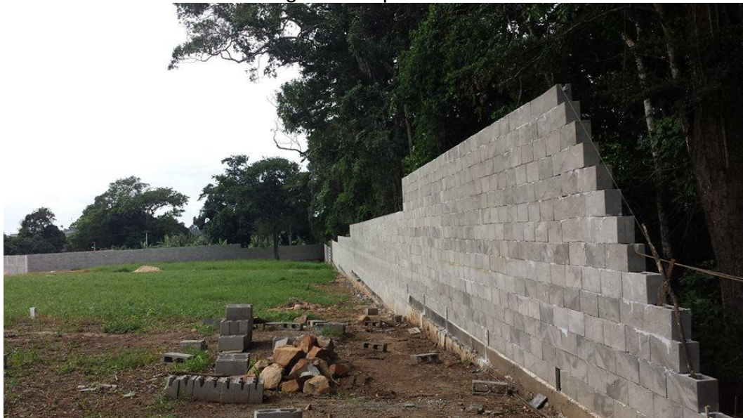
FIGURA 10 – Limpeza do canteiro de obras no processo de assentamento com argamassa polimérica
