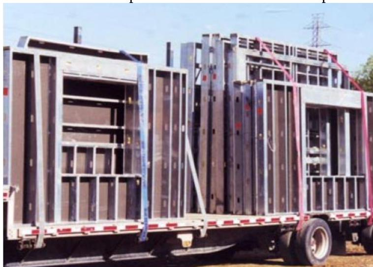
FIGURA 09 - Painéis em LSF produzidos em fábricas e transportados para obra.
