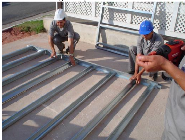
FIGURA 08 – Montagem do painel em LSF no canteiro de obras.
