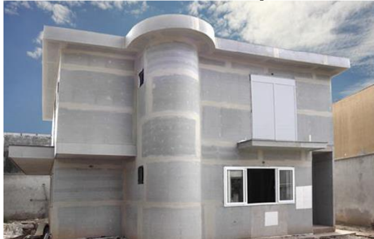
FIGURA 23 – Fechamento externo com placas cimentícias.
