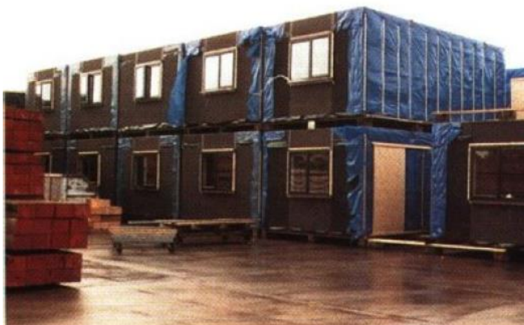
FIGURA 10 – Construção de edifício em módulos.
