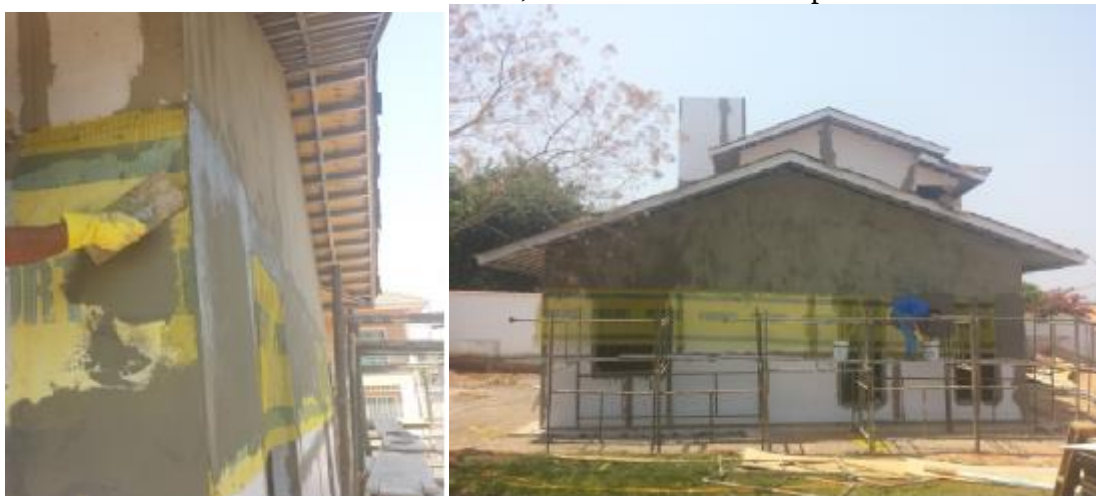
FIGURA 27 – Acabamento com fita, tela e massa sobre as placas cimentícias.
