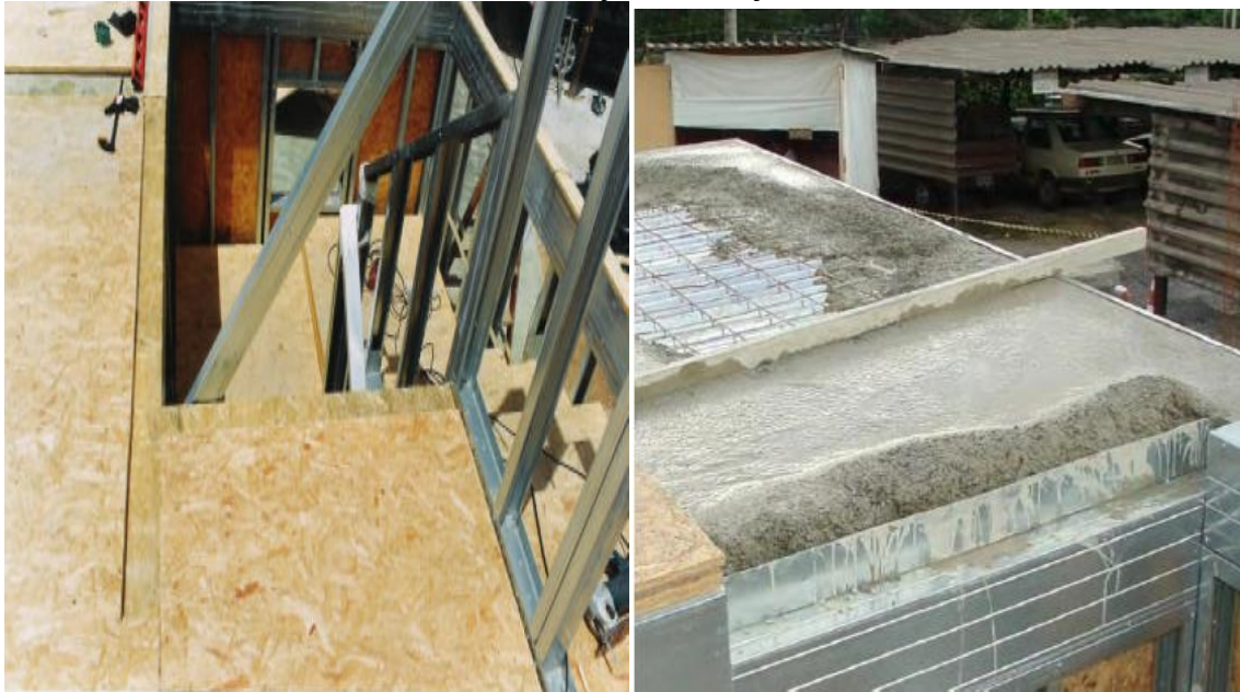
FIGURA 20 – Laje seca e laje úmida.
