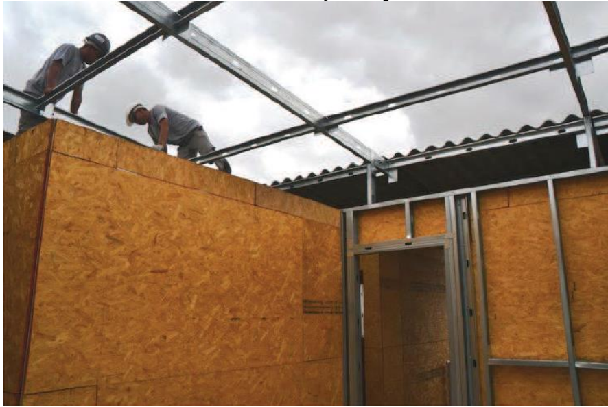
FIGURA 21 – Instalação da placa OSB.
