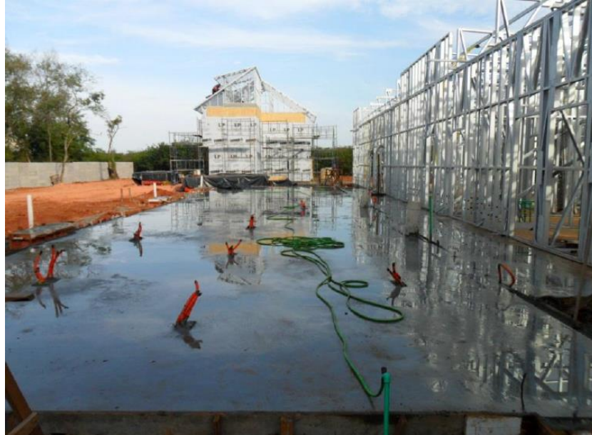
FIGURA 14 – Fundação em radier
