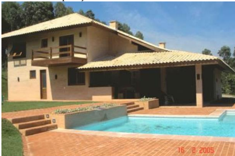
FIGURA 03 – Aplicação do LSF em Residências Unifamiliares.
