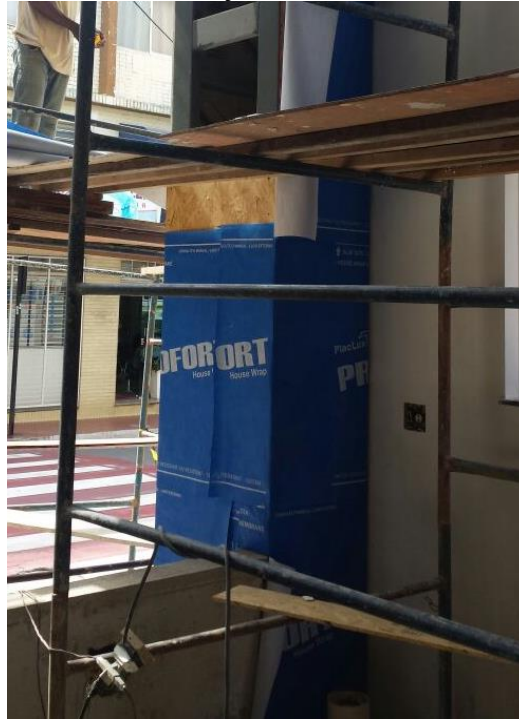
FIGURA 22 – Instalação da membrana hidrófuga.
