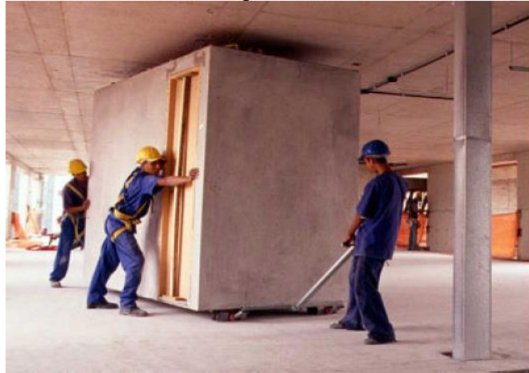
FIGURA 11 – Montagem de módulo de banheiro
