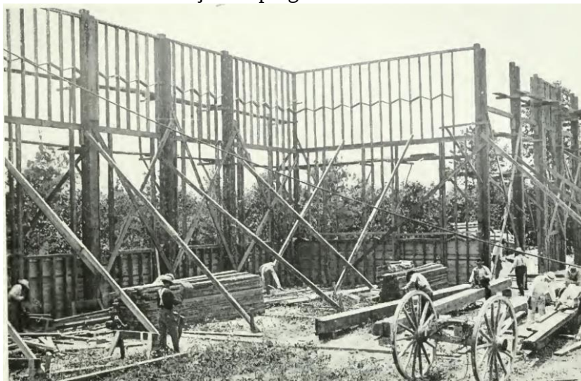
FIGURA 01 – Construção empregando o método Balloon Framing .
