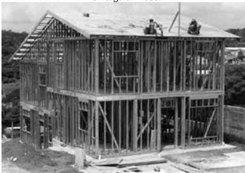
FIGURA 02 – Protótipo de residência em Light Steel Framing na Exposição Mundial de Chicago em 1933.
