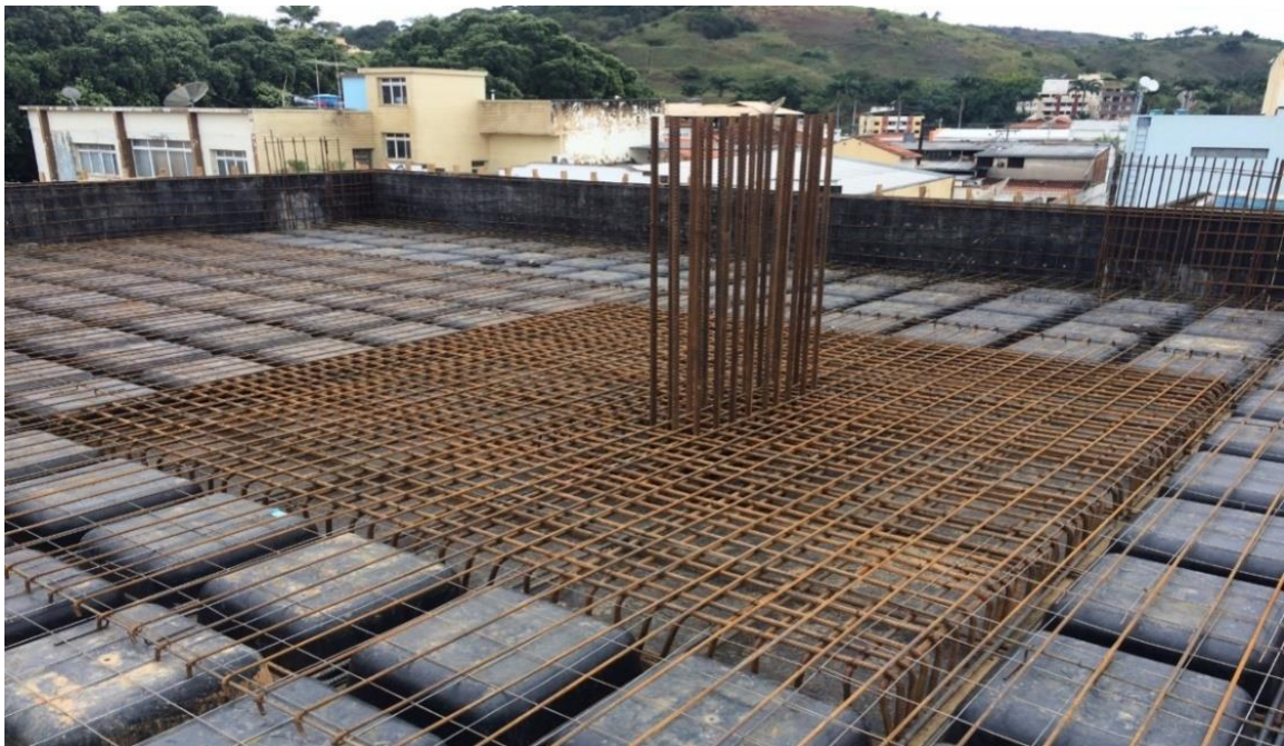
FUGURA 14 – Capitel sendo armado
