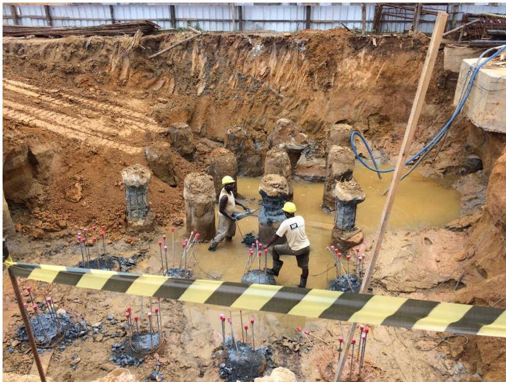
FIGURA 15 – Rebaixamento das estacas
