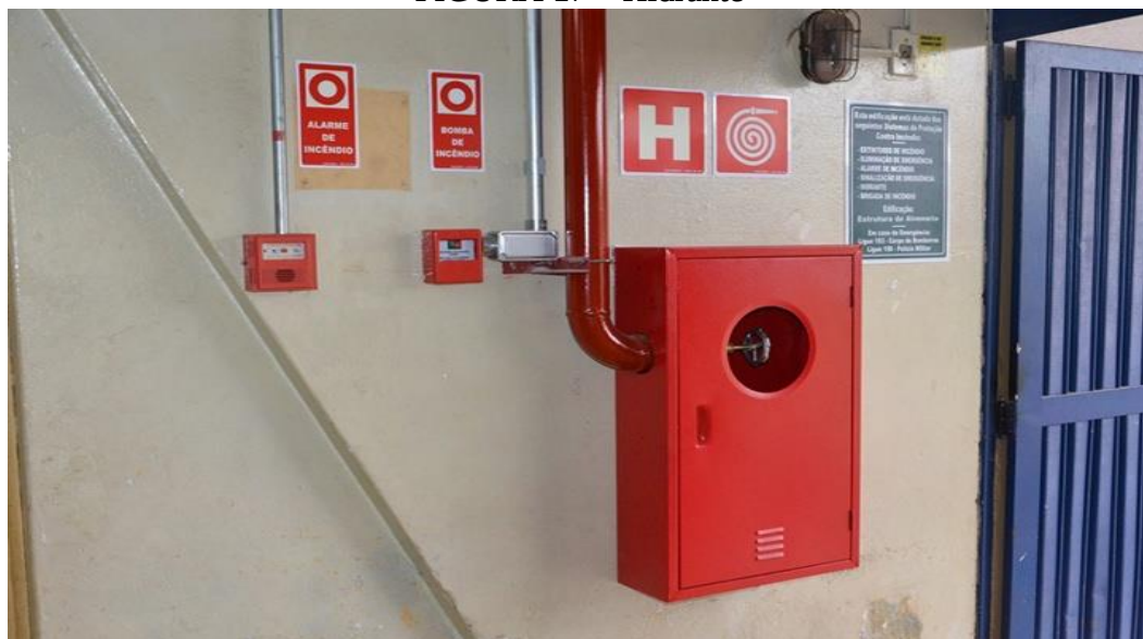
FIGURA 17 – Hidrante
