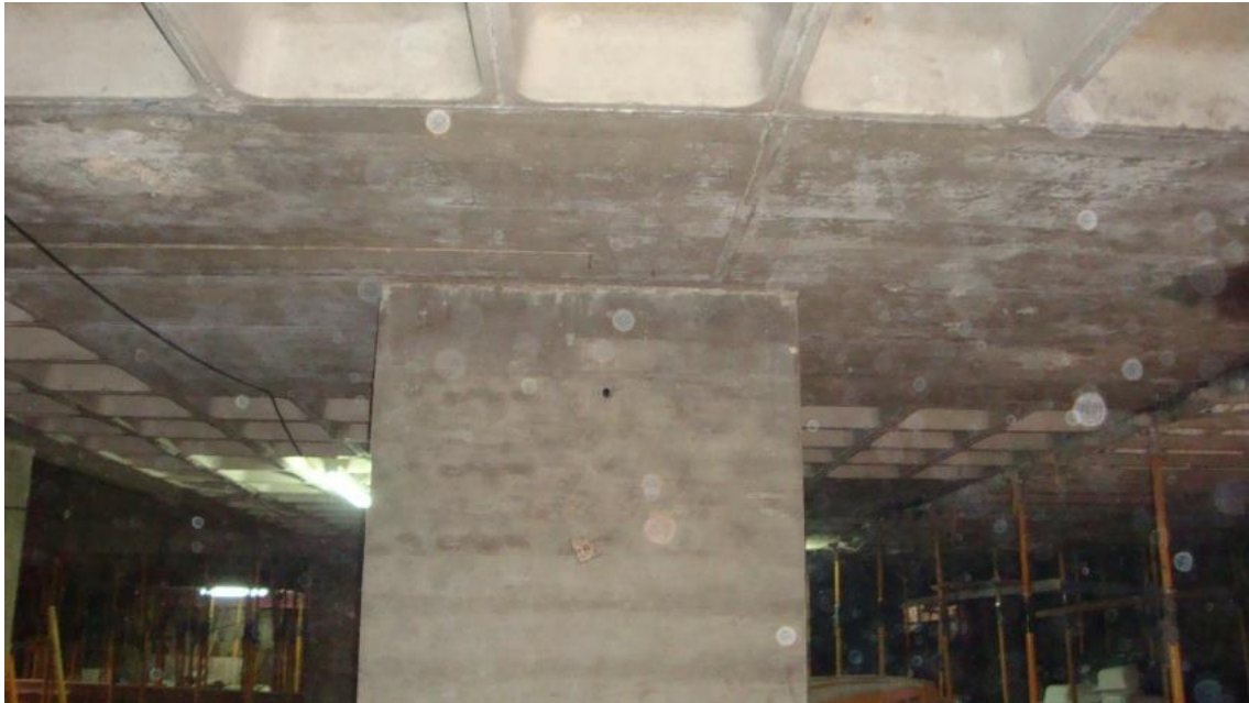
FIGURA 13 – Capitel em torno do pilar
