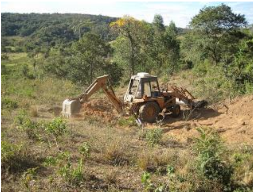
FIGURA 10 5 - Preparação do terreno.
