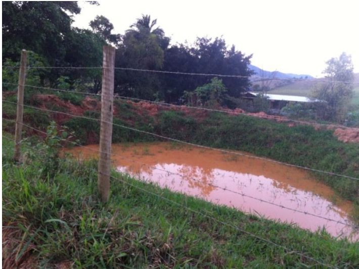
FIGURA 04 - Barraginha em beira de estrada.
