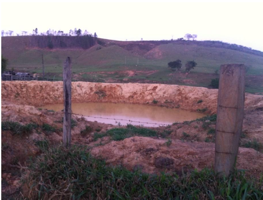
FIGURA 14 - Barraginha finalizada com água.
