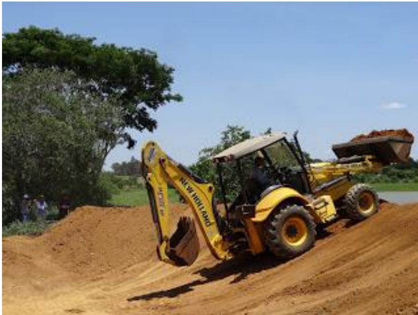
FIGURA 12 7 - Retirada da terra do centro para extremidade.
