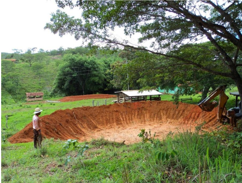
FIGURA 13 8 - Barraginha finalizada sem água.
