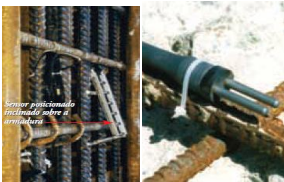
FIGURA 11 - Sensores posicionados sobre a armadura
