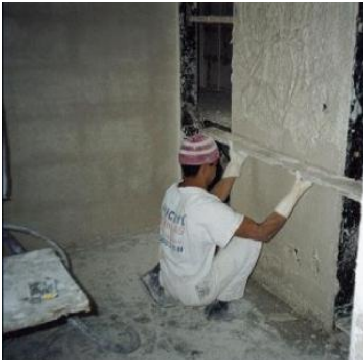
Figura 5 - Gesso sendo Sarrafeado
