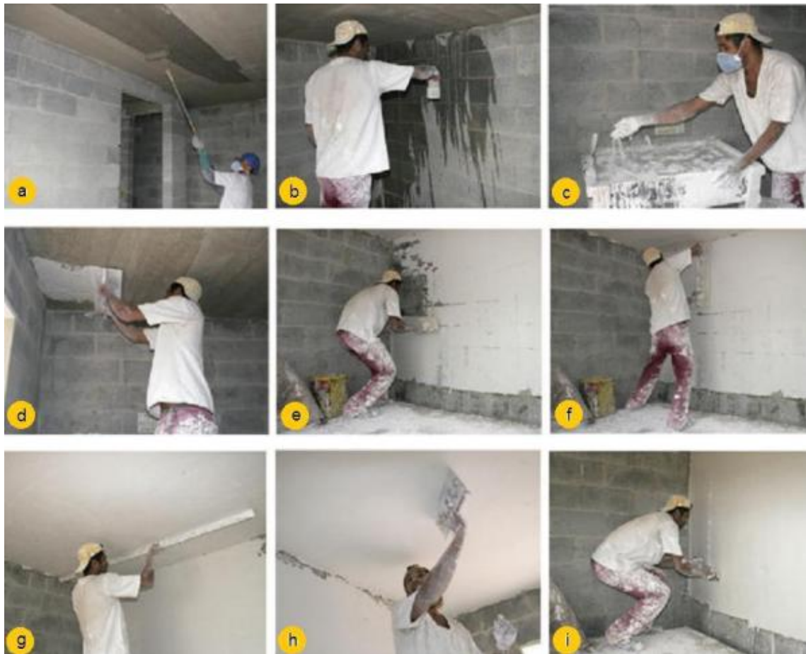
Figura 3 - Aplicação de Gesso Desempenado
