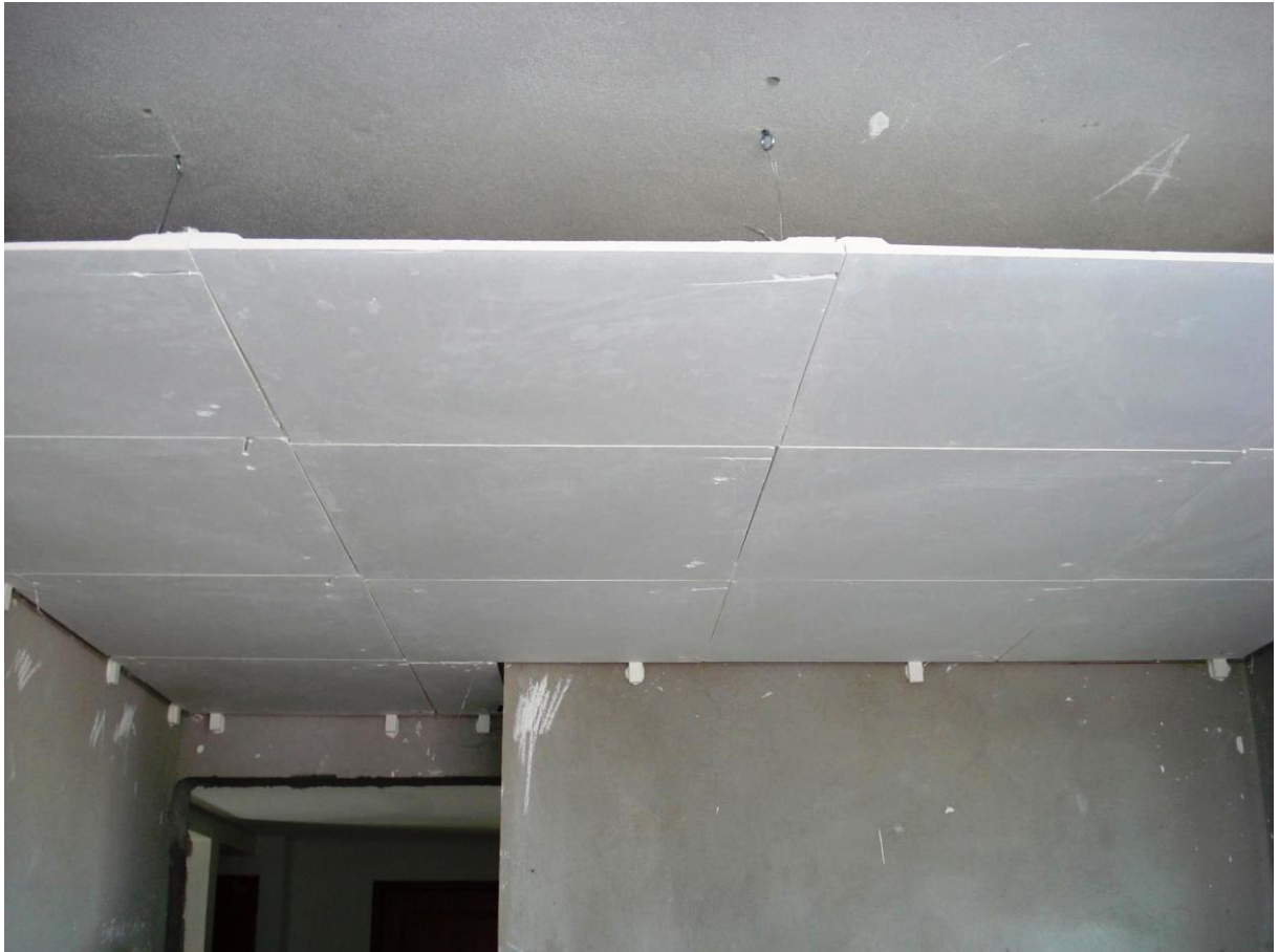
Figura 8 - Aplicação de Forro em Placa de Gesso
