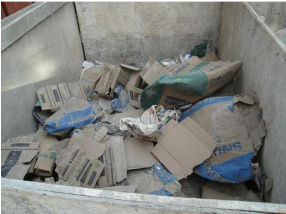
FIGURA 5 - Baía contendo restos de sacos de cimento e papelão.
