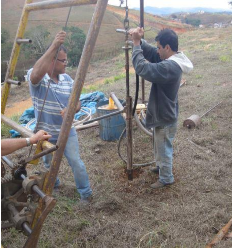
FIGURA 7 – Avanço por circulação de água, utilizando o trépano.
