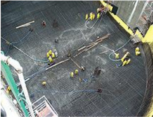
FIGURA 15 – Laje estação Amarela do Metrô de São Paulo
