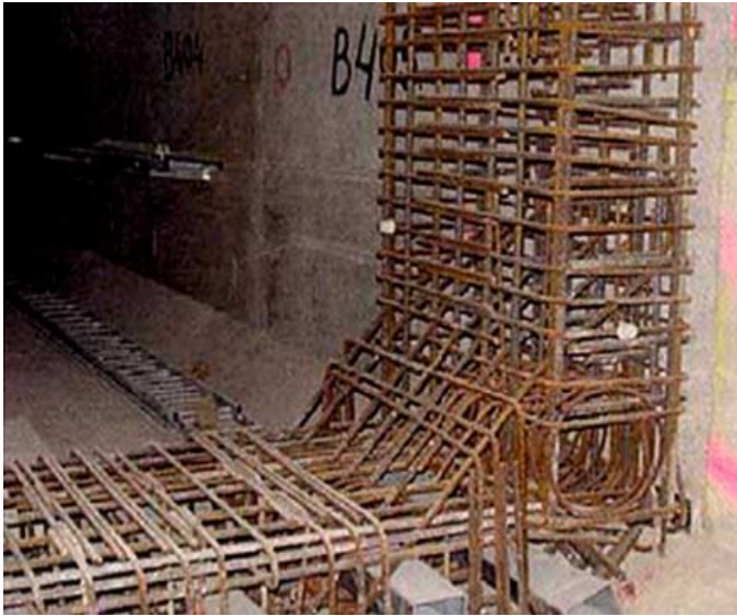
FIGURA 14 – Vista da armadura da estrutura da ponte The Katelbridge.
