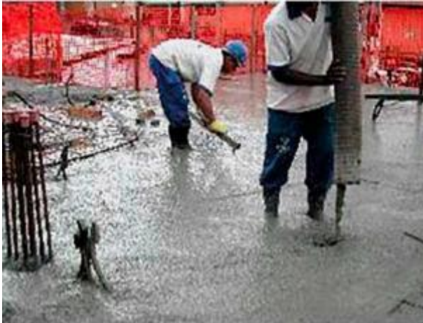
FIGURA 17 – Laje sendo concretada com o CAA com poucos trabalhadores.
