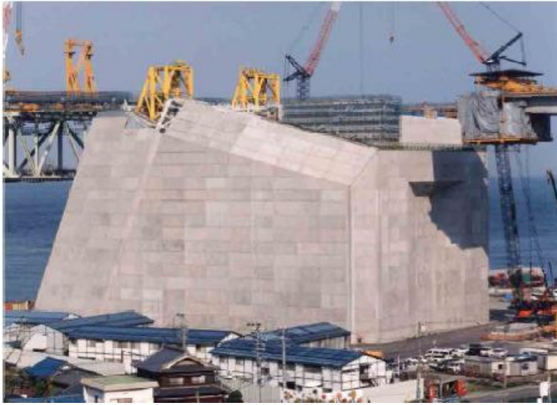
FIGURA 13 – Ancoragem da ponte Akashi-Kaikyo
