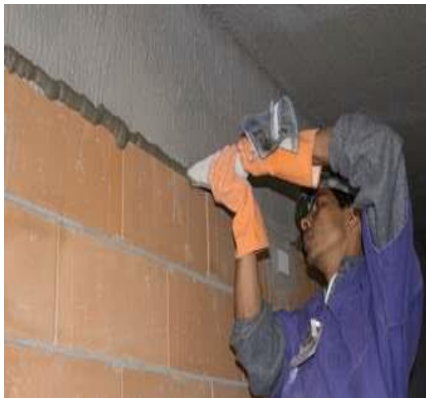
FIGURA 18- Utilização de bisnaga para execução do encunhamento com argamassa expansiva a base de cimento.
