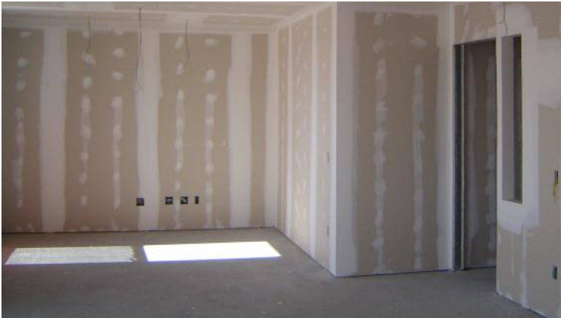
FIGURA 16. Parede pronta para receber massa corrida e pintura.
