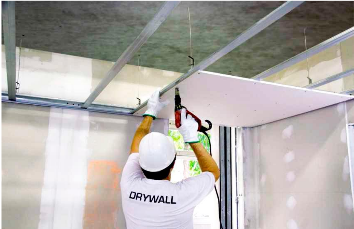
FIGURA 17. Utilização do drywall como forro.
