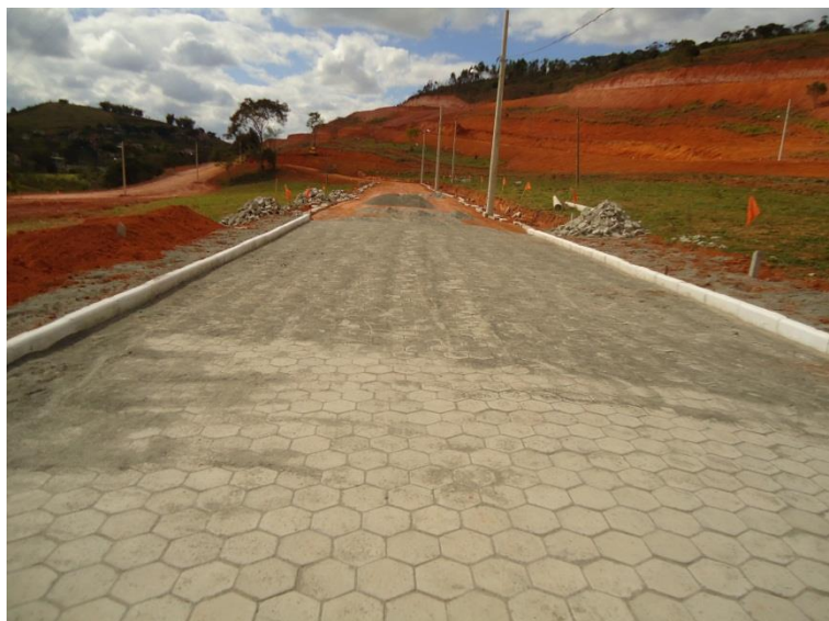
FIGURA 7 – Rejuntamento dos blocos
