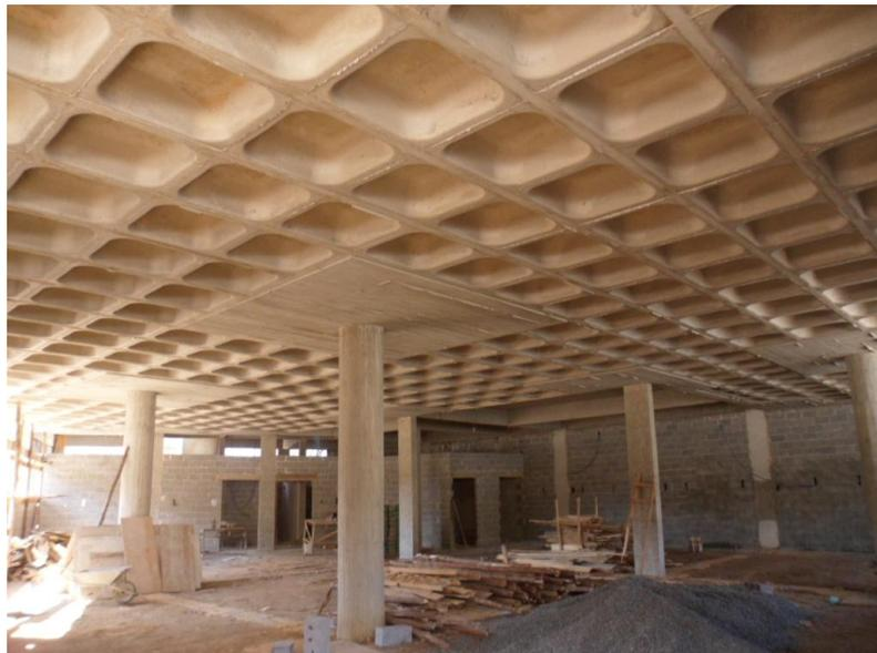
Utiliza-se um tablado de madeira como suporte para o isopor, que tem a finalidade de fôrma. Por ser um material inerte, pode ser mantido na estrutura da laje, melhorando sua isolamento térmica e acústica (FIG. 2).
